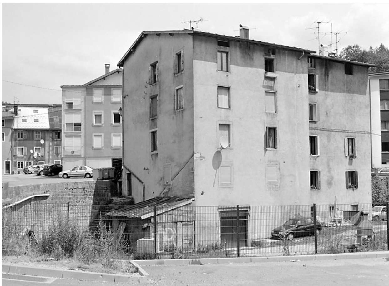
Elévation postérieure, de trois quarts gauche.
