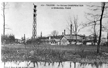
Valdoie. Les usines Charpentier et Chaudel-Page. Phot. Jérôme Mongreville IVR43_20019000131X
