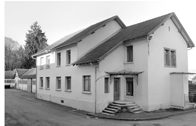
Bâtiment des bureaux. Phot. Jérôme Mongreville IVR43_20019000724X
