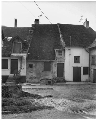
Façade antérieure. Phot. Jérôme Mongreville IVR43_19853900044X
