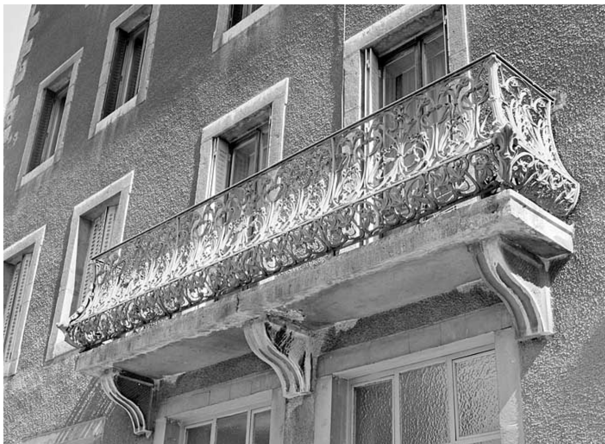
Balcon de l'immeuble.
