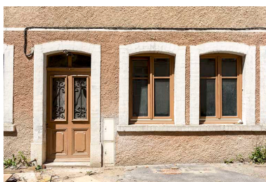
Façade postérieure : porte et fenêtres multiples. Phot. Sonia Dourlot IVR43_20162500876NUC4A
