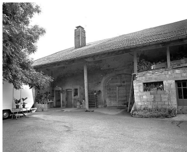
Détail du mur goutterot. Phot. Yves Sancey IVR43_19782500513X
