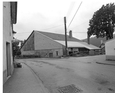
Pignon sur rue et goutterot. Phot. Yves Sancey IVR43_19782500512X
