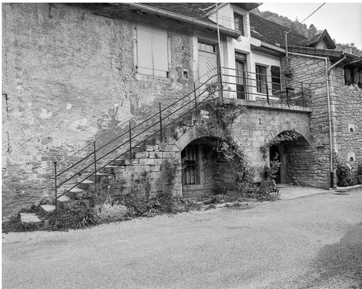
Façade antérieur : escalier à gauche de l'avancée.
