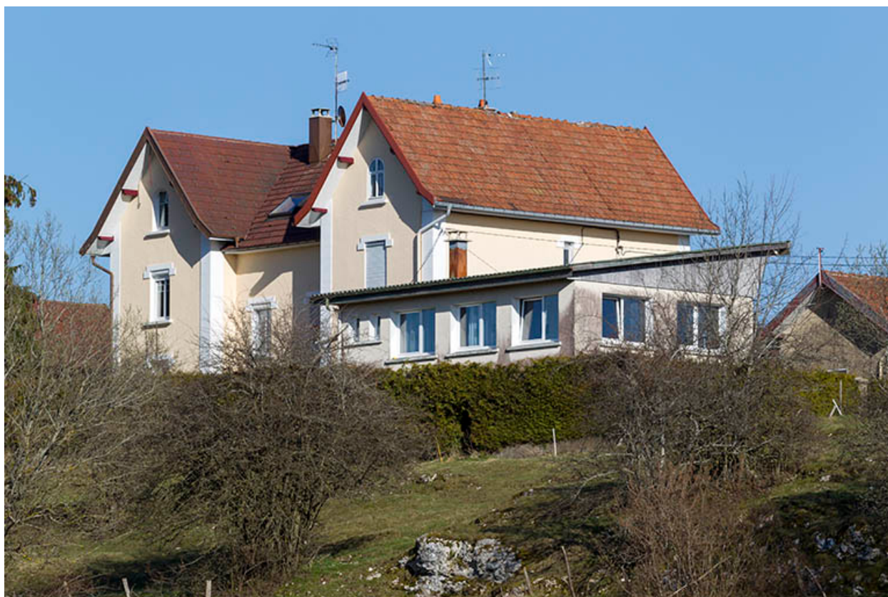
Vue d'ensemble, depuis l'ouest (maison et atelier).
