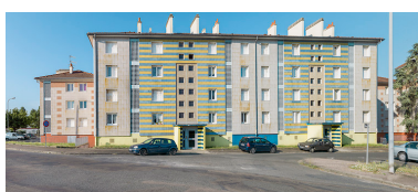
Bâtiment A, façade antérieure est.
