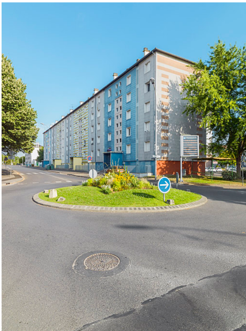
Bâtiment I, façade antérieure.
