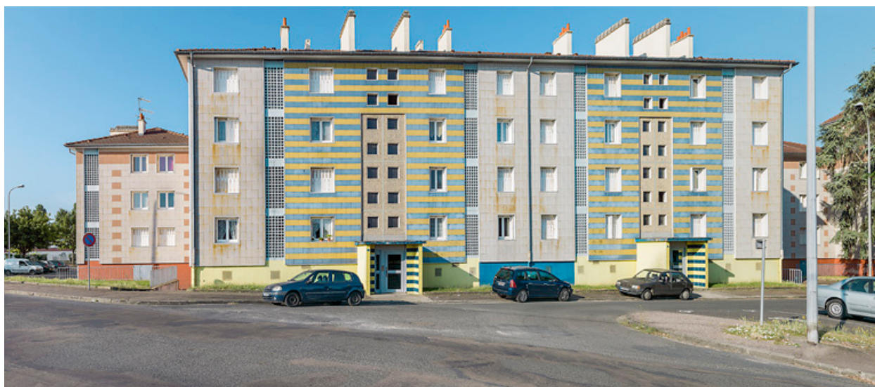
Bâtiment A, façade antérieure est.
