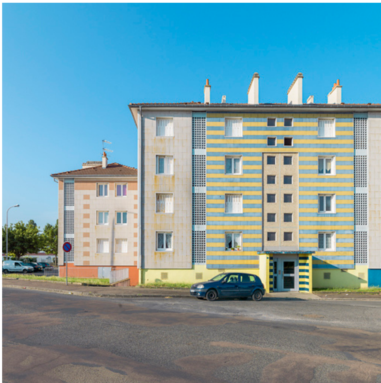
Bâtiment A, façade antérieure.
