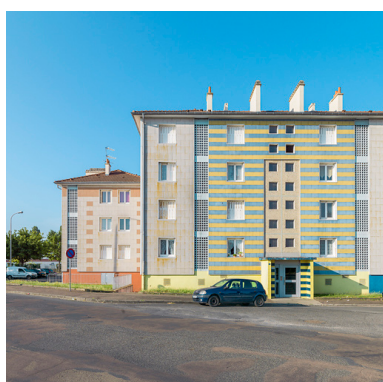
Bâtiment A, façade antérieure.
