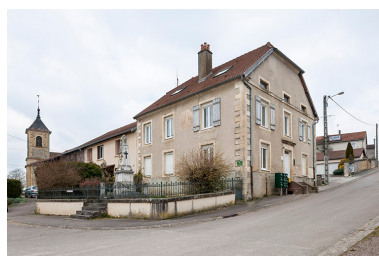
La rue de l'église. Phot. Jérôme Mongreville IVR43_20167000211NUC4A
