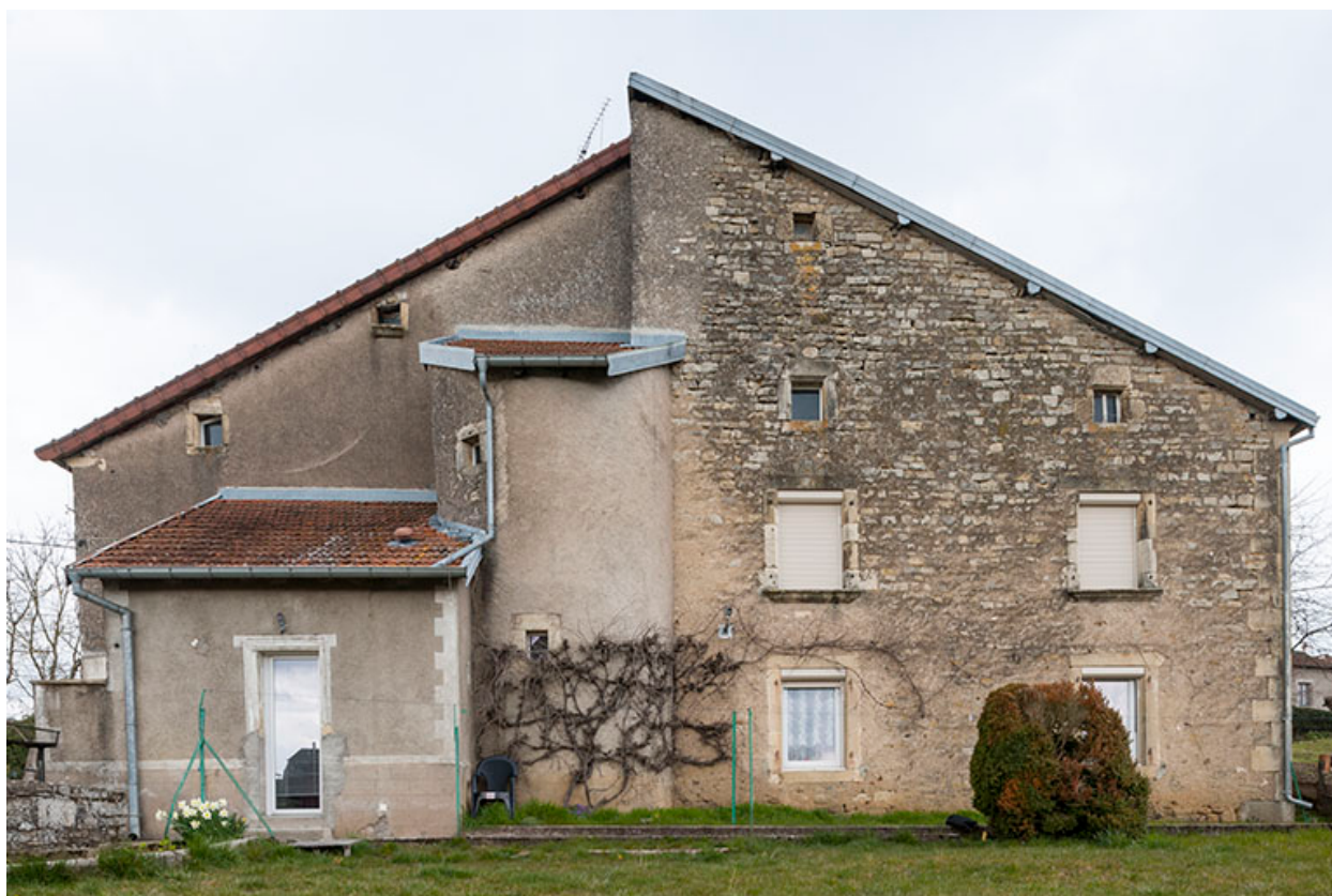
détail sur la maison avec tourelle.
