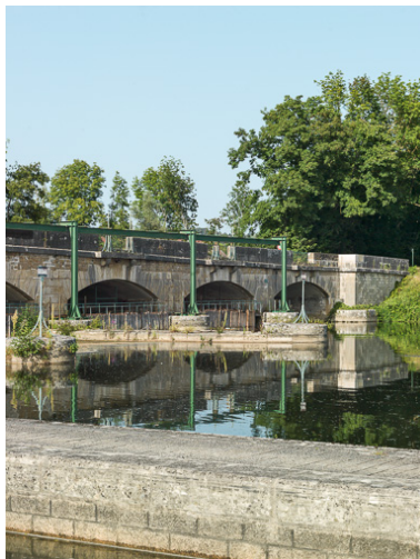
Vue du barrage.
