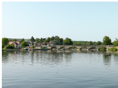
Vue du site.
