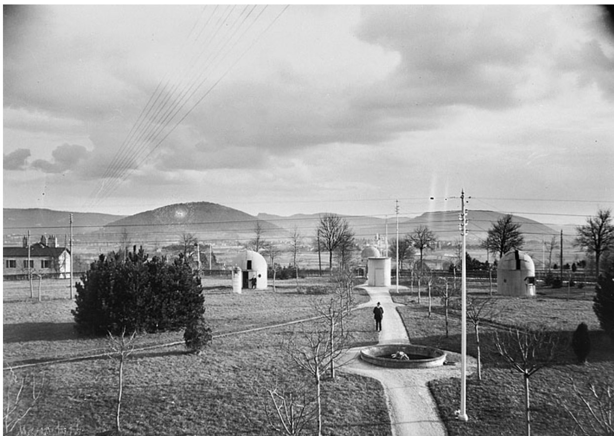
[Vue d'ensemble des coupôles et du bassin, depuis le nord], 1914.
