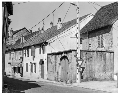
Façade antérieure. Phot. Dominique Dominguez IVR43_19803900163X
