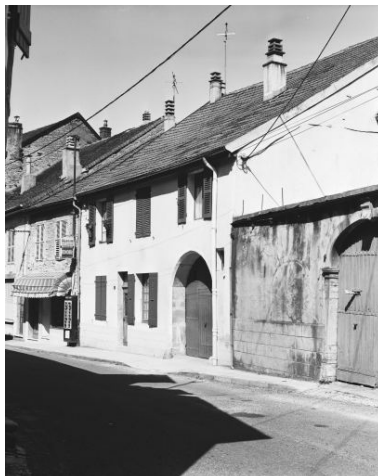
Façade antérieure. Phot. Dominique Dominguez IVR43_19803900164X
