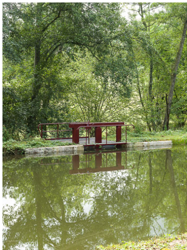
Vue du déversoir. Phot. Pierre-Marie Barbe-Richaud IVR26_20175800280NUC2A
