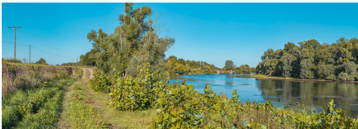
Vue d'ensemble du site du barrage en 2019.
