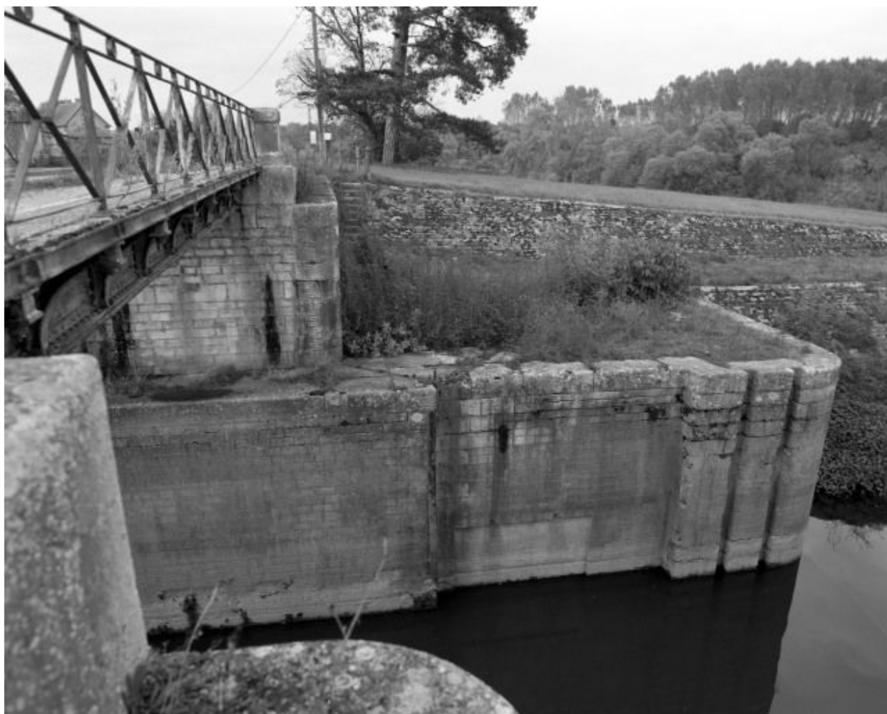
L'entrée est de l'écluse en 2001, détail.
