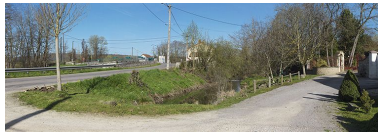
Rigole d'alimentation derrière la maison éclusière. Phot. Thierry Kuntz IVR26_20137100217NUC4A
