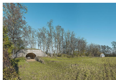
Batterie annexe (droite). Phot. Thierry Kuntz IVR26_20252100513NUC4A
