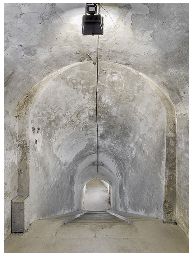
Escalier-rampe en direction de la double caponnière. Phot. Thierry Kuntz IVR26_20252100489NUC4A
