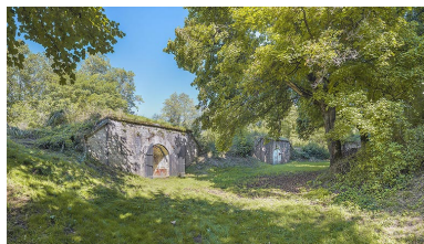
La rue des Remparts. Phot. Thierry Kuntz IVR26_20252100254NUC4A
