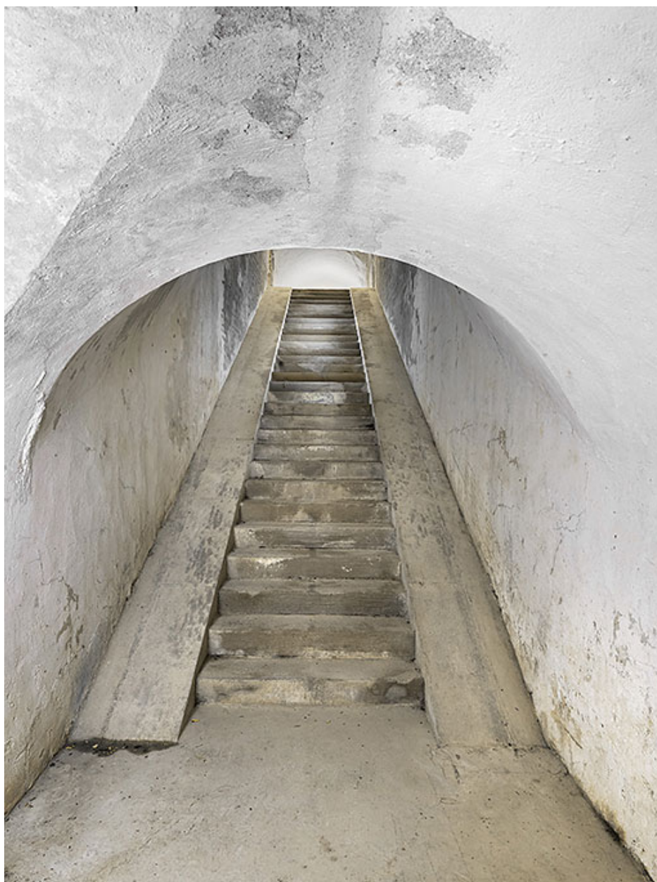
Escalier-rampe, vue montante.
