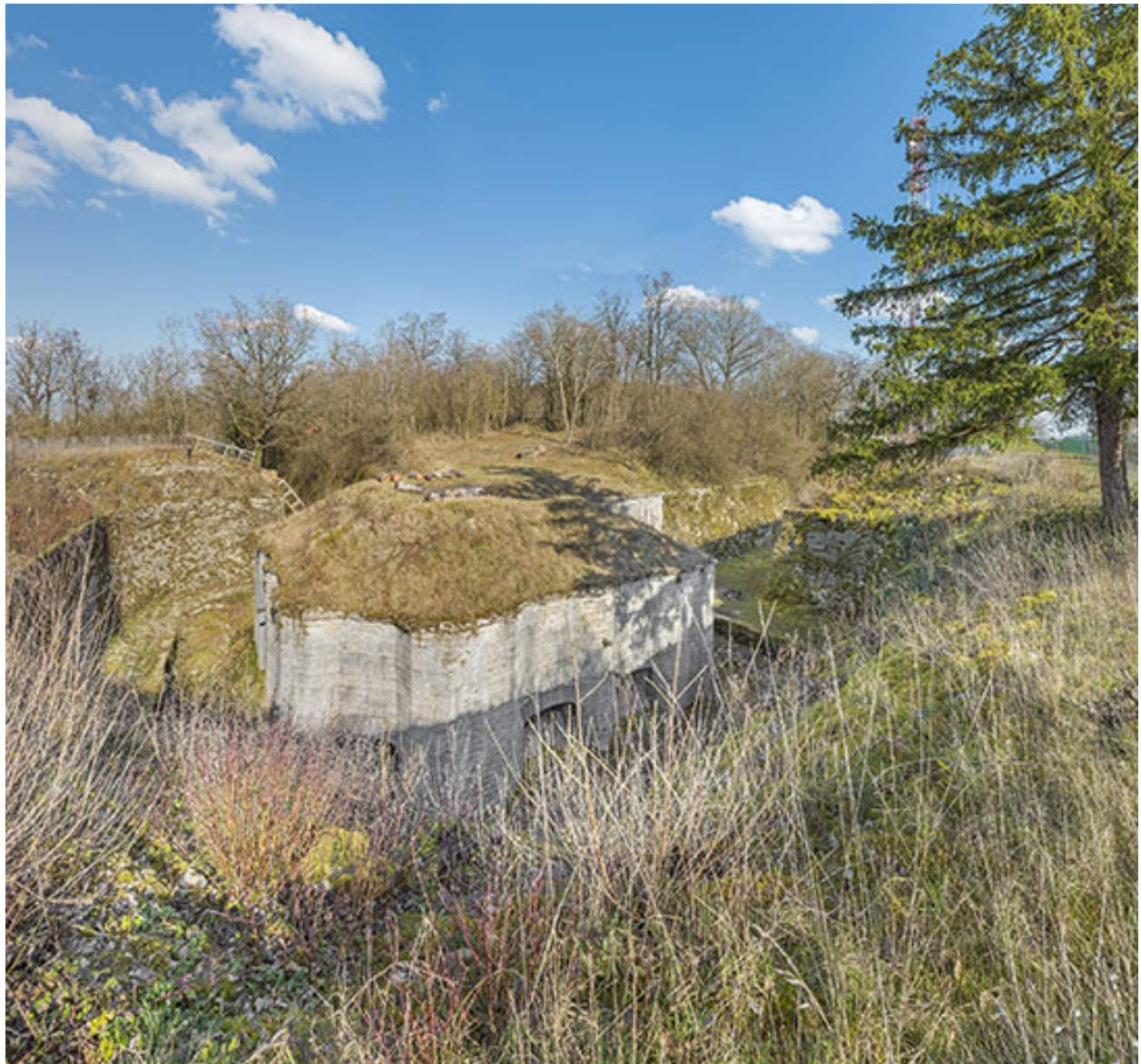
Vue de la caponnière depuis la contrescarpe.
