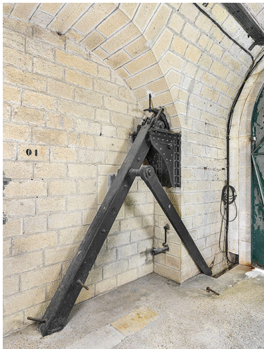
Détail de la bielle pendante. Phot. Thierry Kuntz IVR26_20252100228NUC4A
