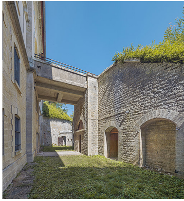
La gorge de la double caponnière. Phot. Thierry Kuntz IVR26_20252100475NUC4A
