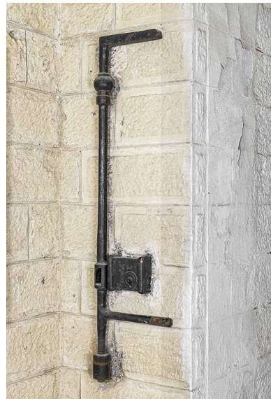
Taquet pivotant bloquant ou activant la bascule du pont. Phot. Thierry Kuntz IVR26_20252100231NUC4A
