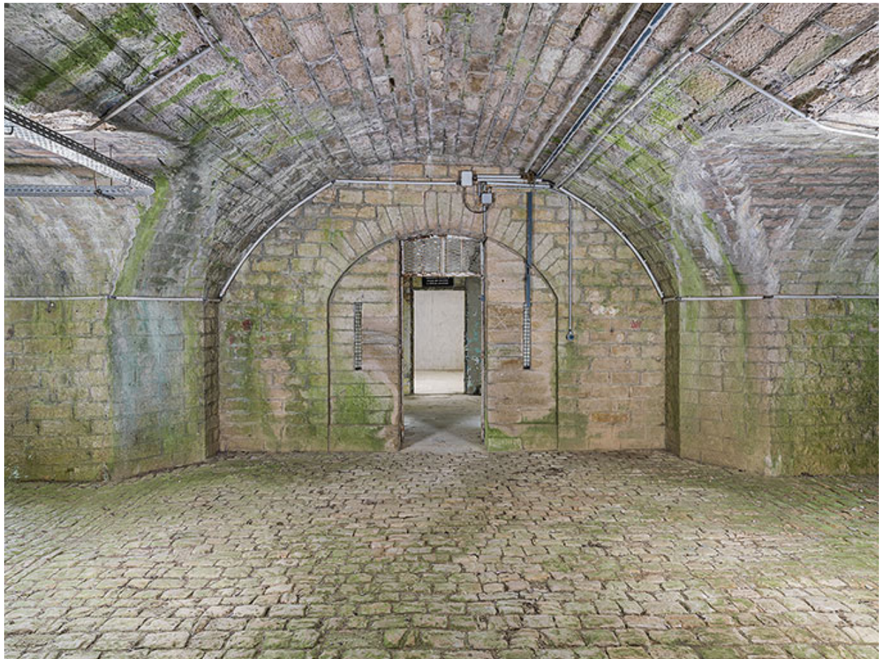
Traverse-abri enracinée de la capitale.
