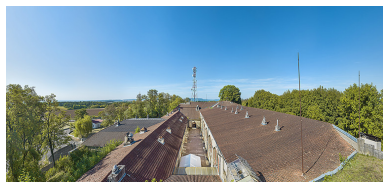
Vue depuis le nord-ouest de la cour et des casernes. Phot. Thierry Kuntz IVR26_20252100234NUC4A
