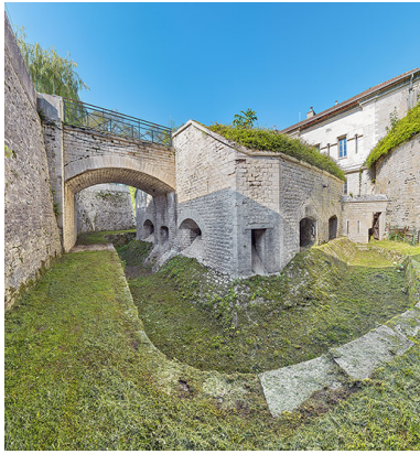
La double caponnière du front de gorge et son fossé diamant. Phot. Thierry Kuntz IVR26_20252100222NUC4A
