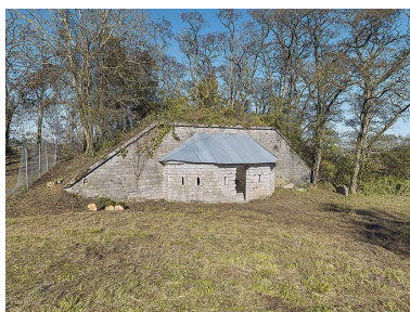
Traverse-abri de la batterie à gorge retranchée. Phot. Thierry Kuntz IVR26_20252100517NUC4A
