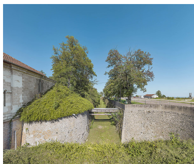
Fossé du front de gorge.
