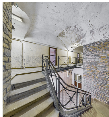
L'escalier entre le premier étage et le rez-de-chaussée. Phot. Thierry Kuntz IVR26_20252100450NUC4A
