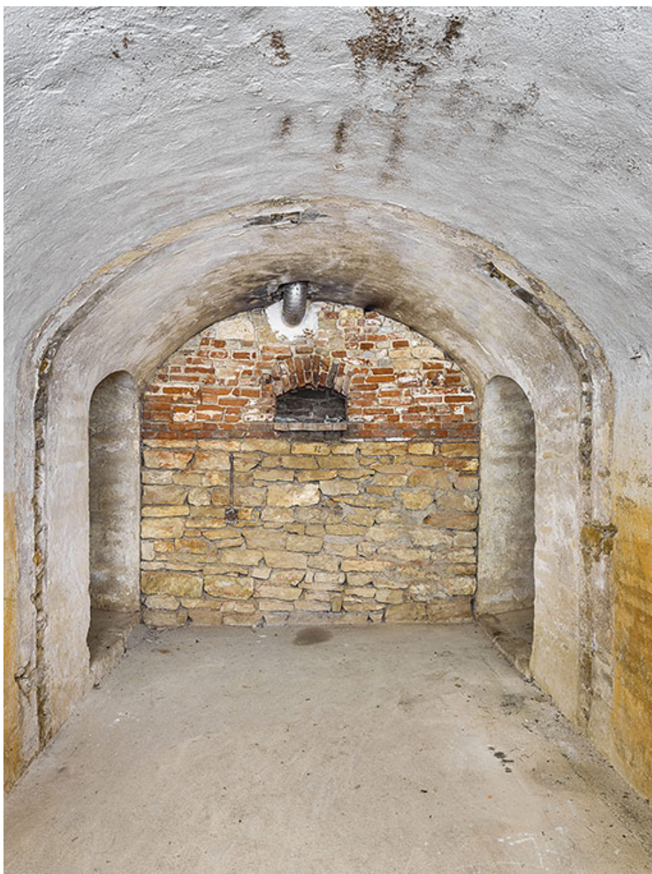
Galerie latérale droite de la caserne.
