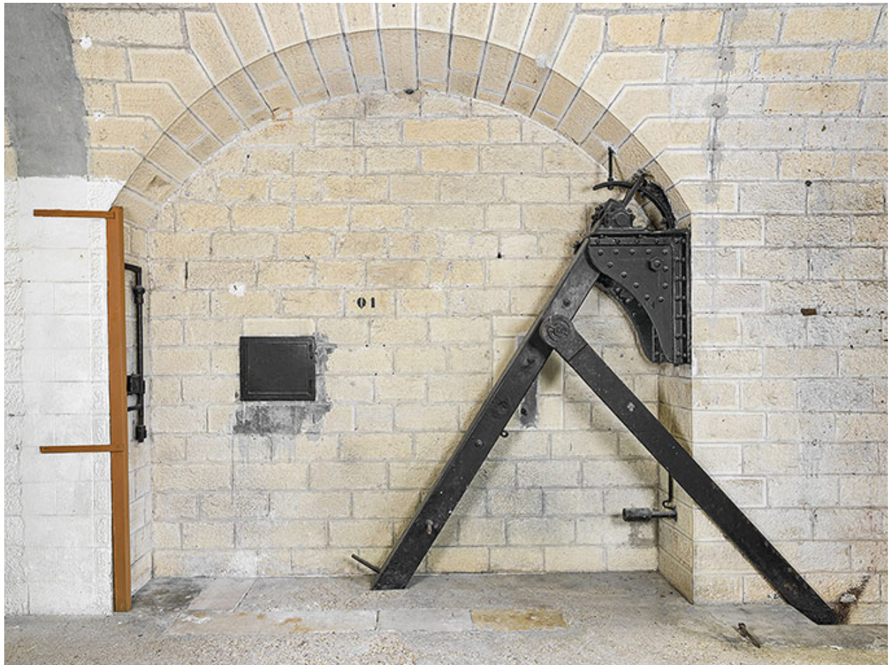
Mécanisme du pont-levis.
