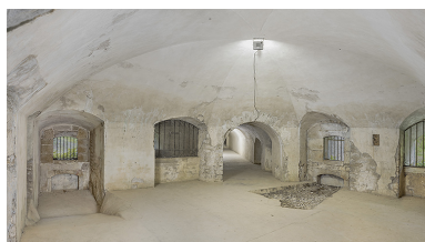
Vue intérieure de la double caponnière et sa gaine d'accès en arrière-plan. Phot. Thierry Kuntz IVR26_20252100498NUC4A
