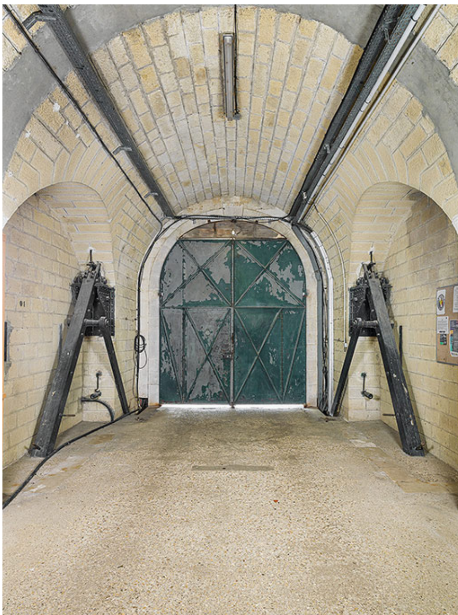
Sas d'entrée du fort, vantaux fermés.
