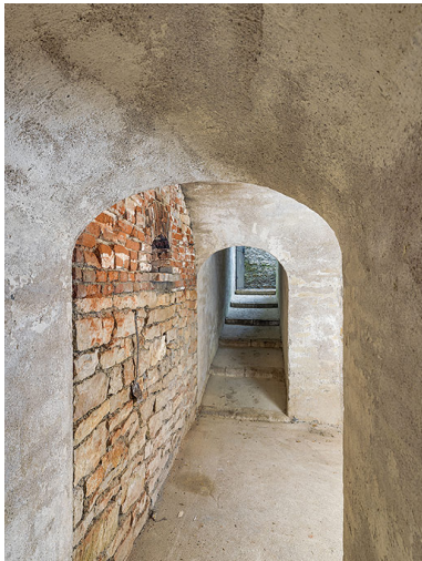
Passage vers les plateformes de tir (front de gorge). Phot. Thierry Kuntz IVR26_20252100242NUC4A
