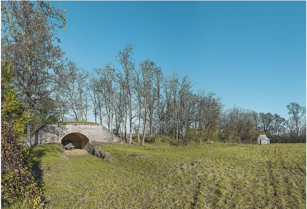
Batterie annexe (droite).
