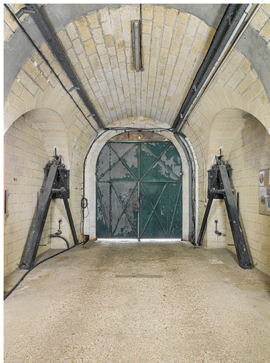
Sas d'entrée du fort, vantaux fermés. Phot. Thierry Kuntz IVR26_20252100226NUC4A
