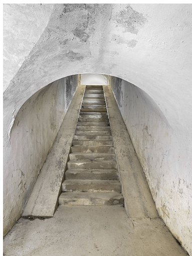
Escalier-rampe, vue montante.
