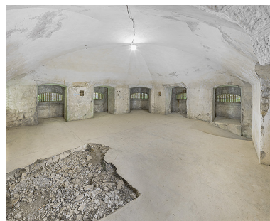
Vue intérieure de la double caponnière avec ses créneaux de tir. Phot. Thierry Kuntz IVR26_20252100496NUC4A
