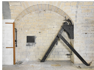
Mécanisme du pont-levis. Phot. Thierry Kuntz IVR26_20252100227NUC4A
