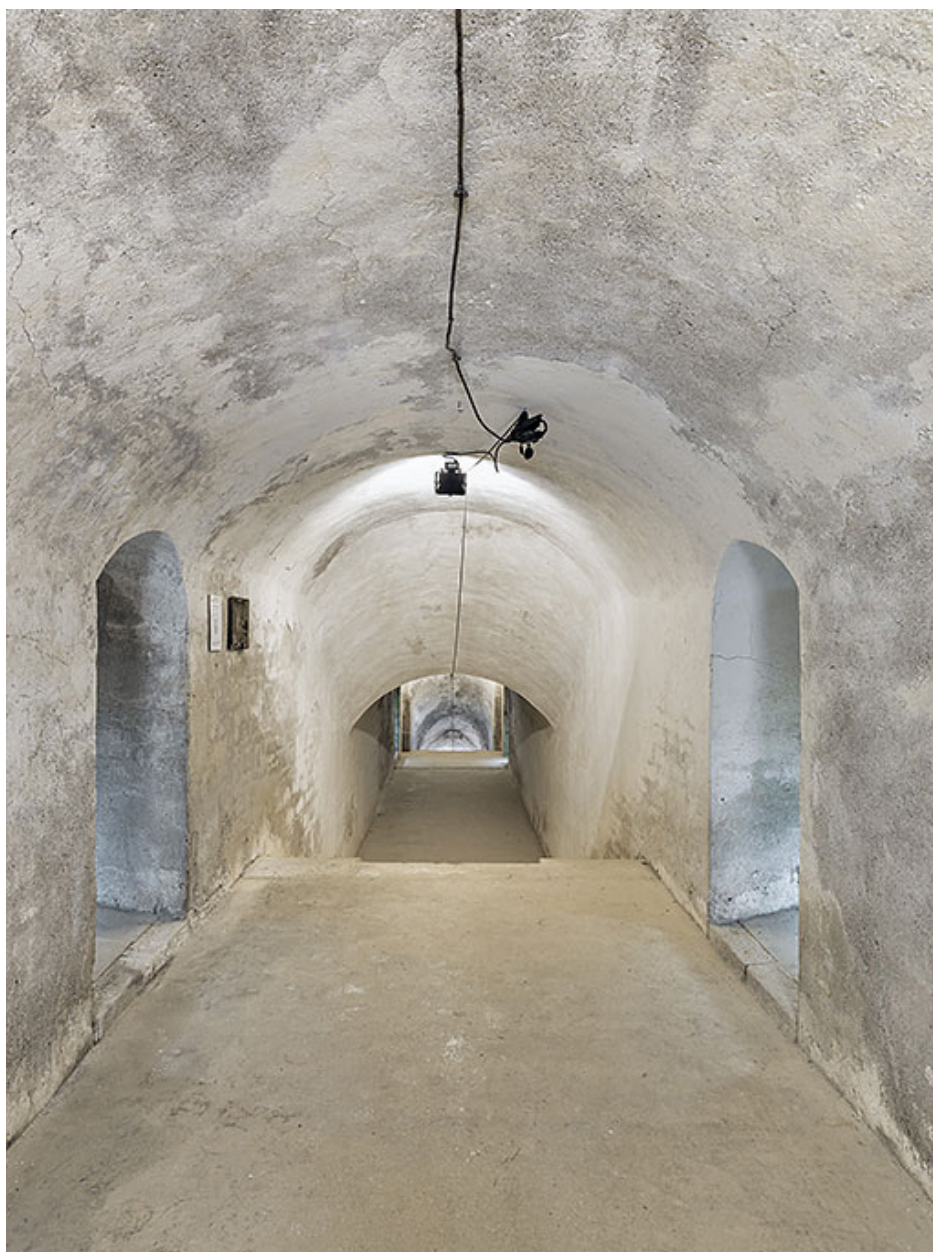
La gaine en direction de la double caponnière et ouvertures latérales vers les plateformes de tir.
