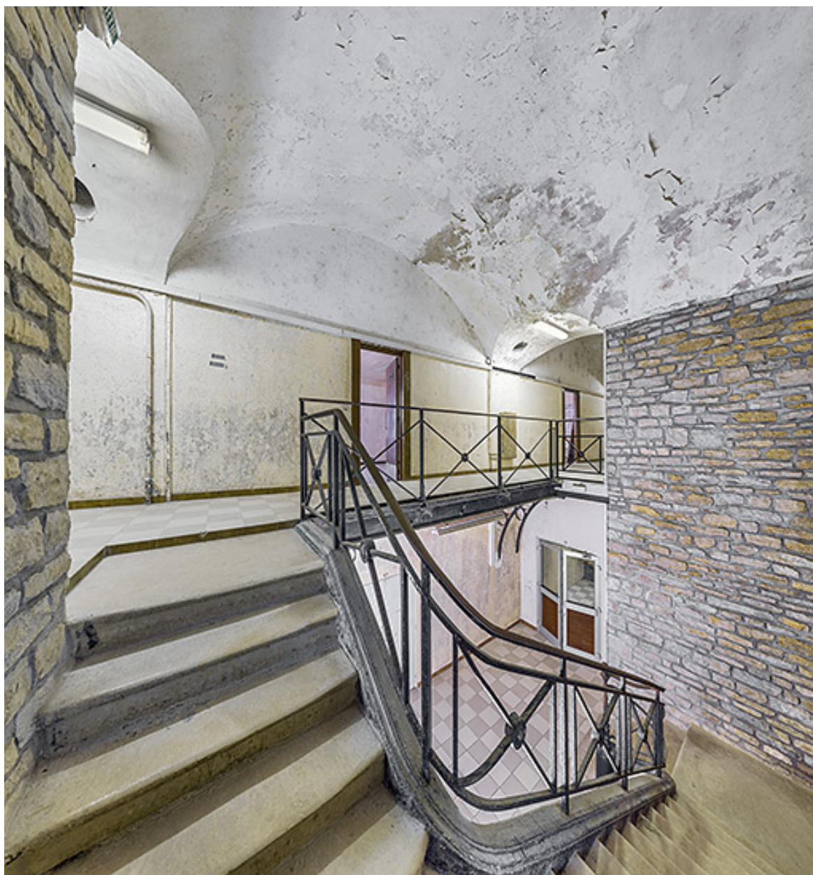
L'escalier entre le premier étage et le rez-de-chaussée.
