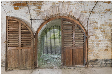
Porte d'accès vers la rue des Remparts, galerie latérale droite de la caserne. Phot. Thierry Kuntz IVR26_20252100247NUC4A
