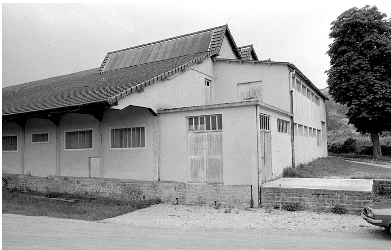
Extrémité ouest de l'atelier de fabrication.
