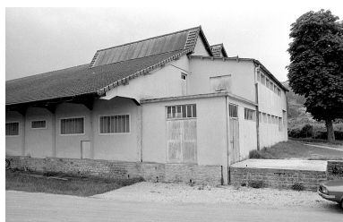
Extrémité ouest de l'atelier de fabrication.
