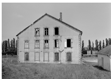
Façade postérieure du logement patronal et bureau.
