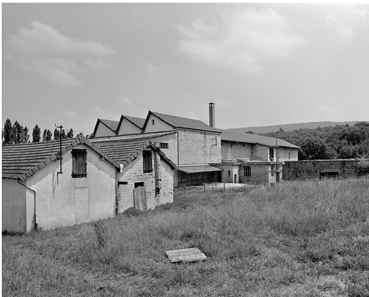
Remises et atelier de fabrication.
