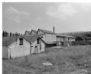
Remises et atelier de fabrication.
