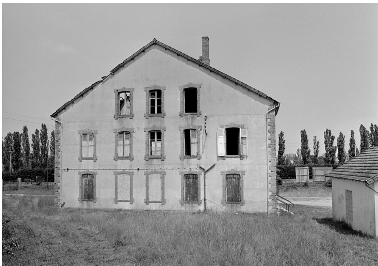
Façade postérieure du logement patronal et bureau.
