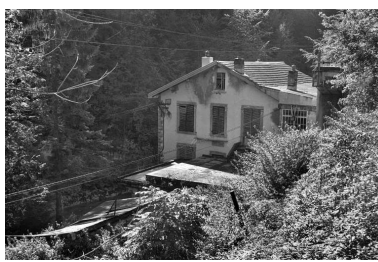
Façade antérieure, vue en plongée. Phot. Laurent Poupard IVR43_19903900528Z
