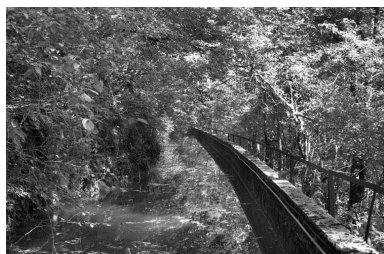
Canal d'amenée. Phot. Laurent Poupard IVR43_19903900530Z
