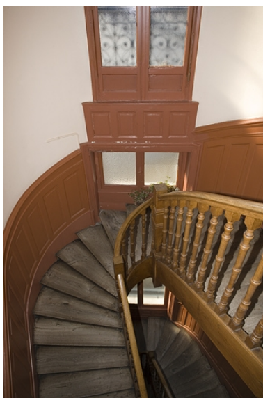
Détail d'une partie de l'escalier.
