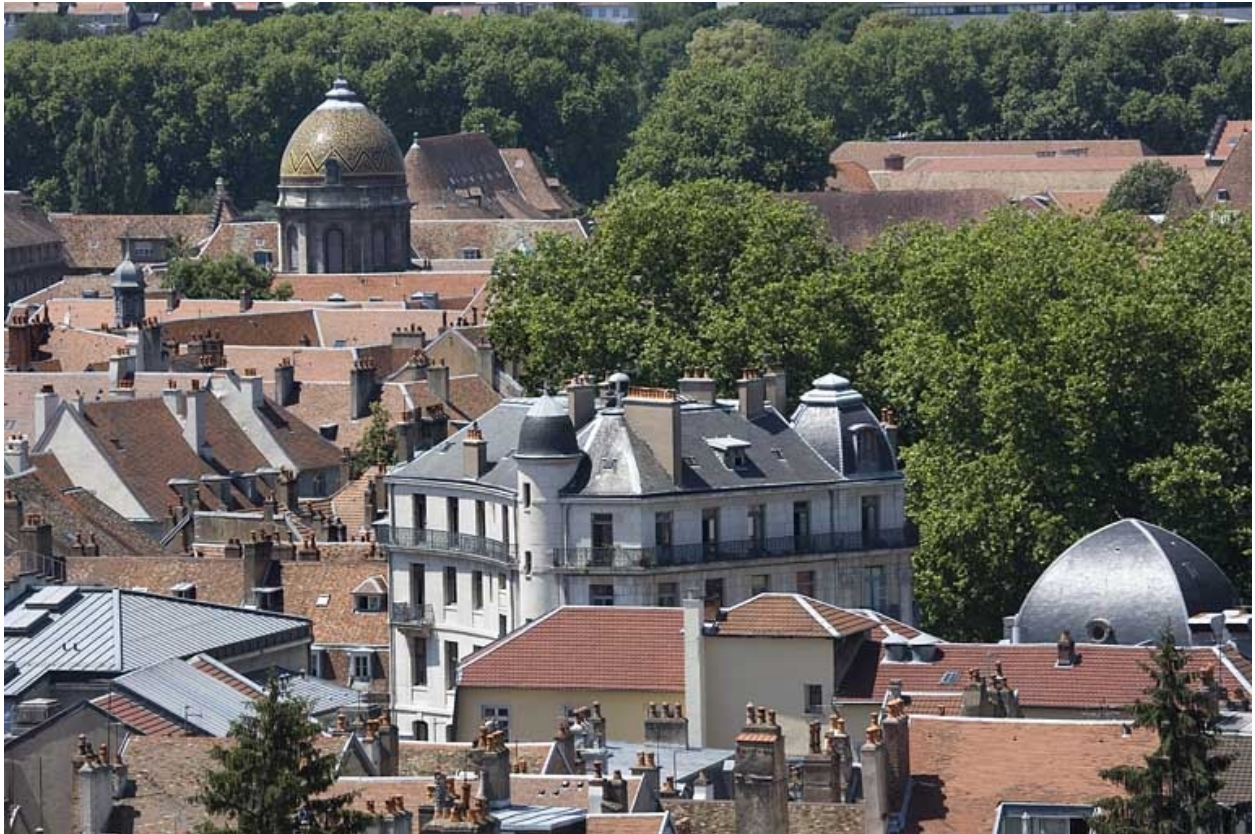
Vue d'ensemble éloignée.
