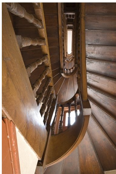
Vue d'ensemble de l'escalier.
