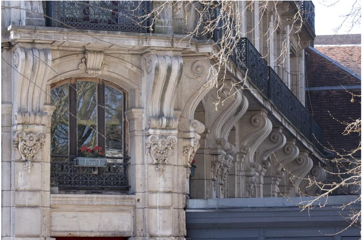
Détail des consoles soutenant le balcon filant.
