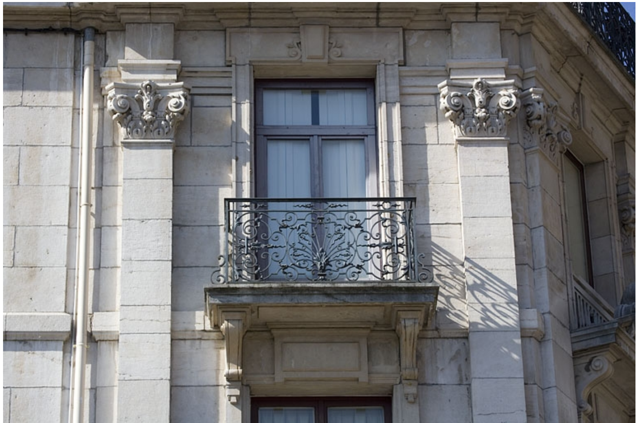
Détail d'un balcon ponctuel entre deux pilastres.
