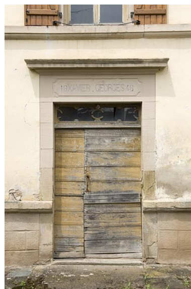
Porte du logement. Phot. Jérôme Mongreville IVR43_20097000365NUC2A
