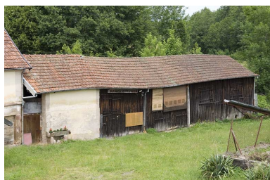
Remises et écuries. Phot. Jérôme Mongreville IVR43_20097000363NUC2A
