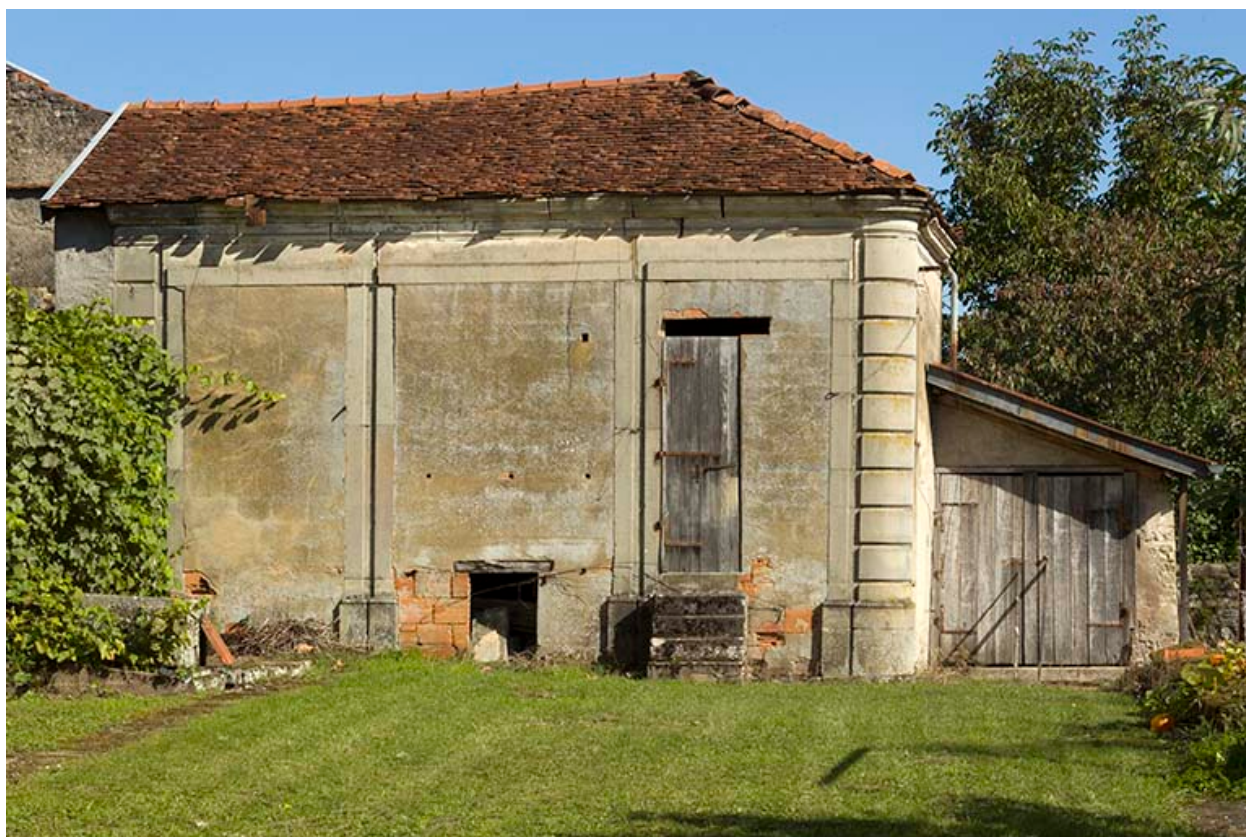
Façade sud de l'édicule du jardin.
