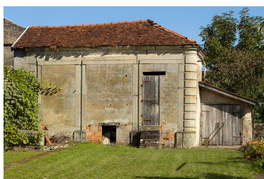
Façade sud de l'édicule du jardin.
