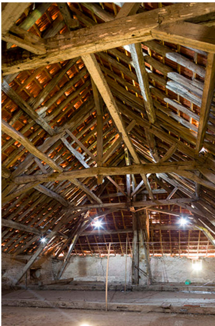
Vue intérieure de la charpente de toit.
