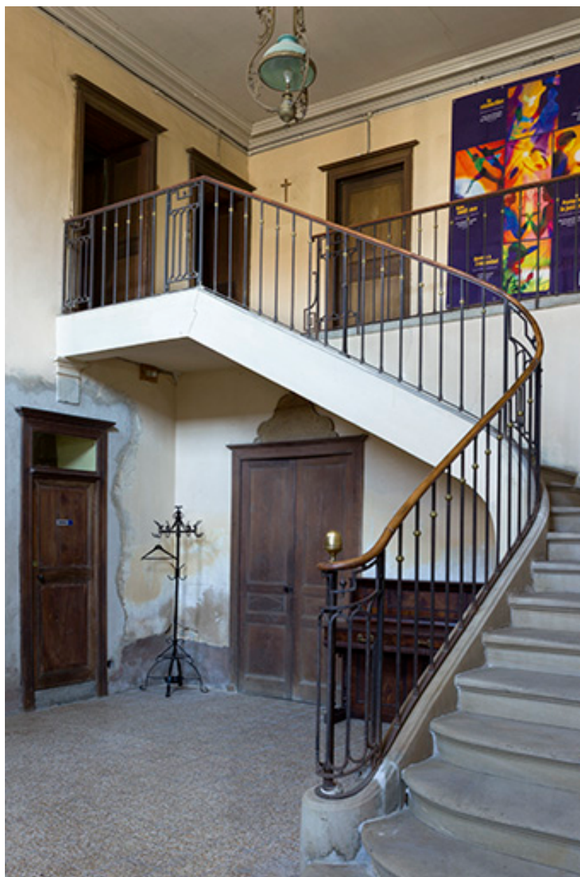
Vue d'ensemble de l'escalier de distribution intérieur.
