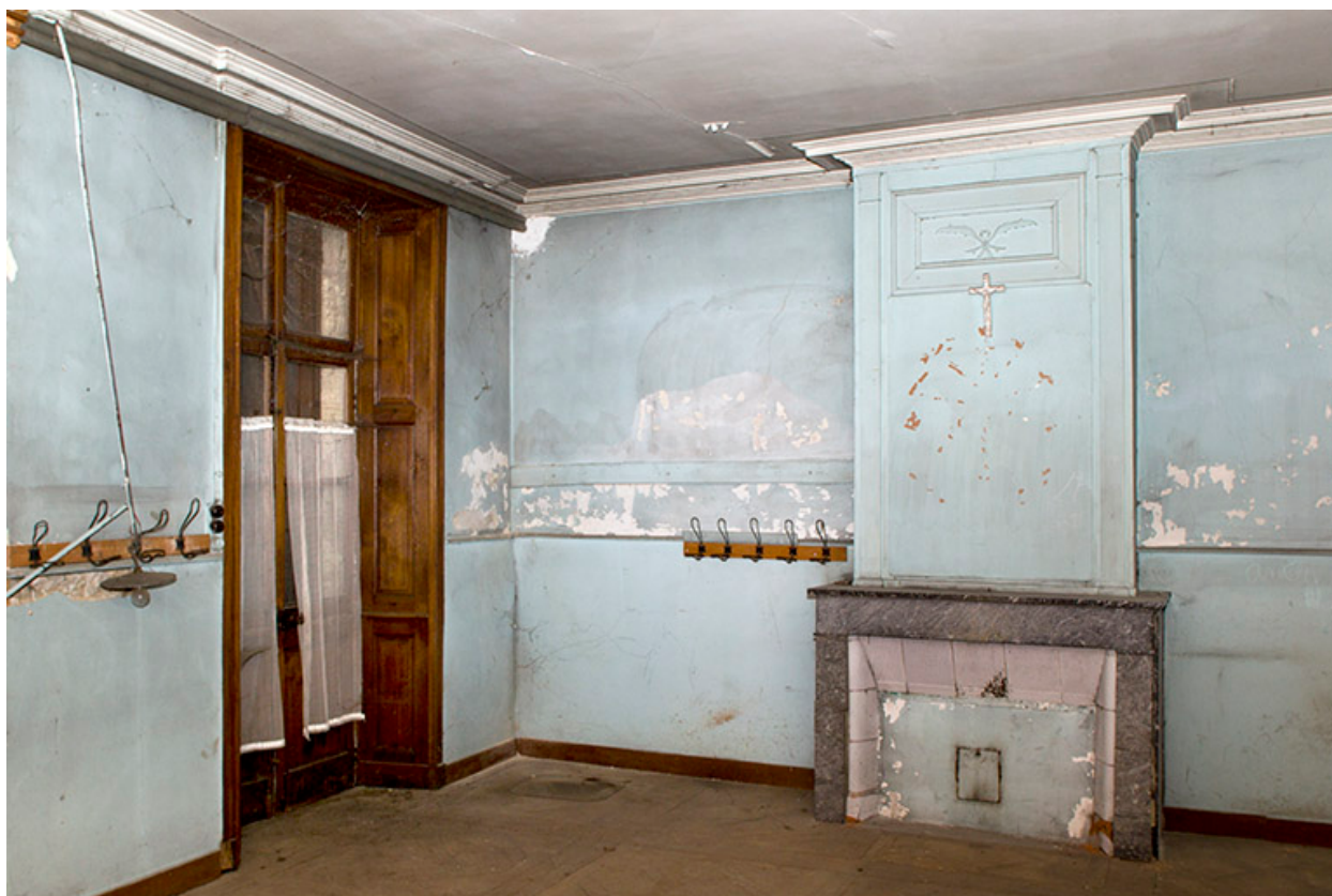
Une chambre en rez-de-chaussée.
