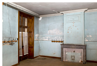
Une chambre en rez-de-chaussée. Phot. Sonia Dourlot IVR43_20157001442NUC2A
