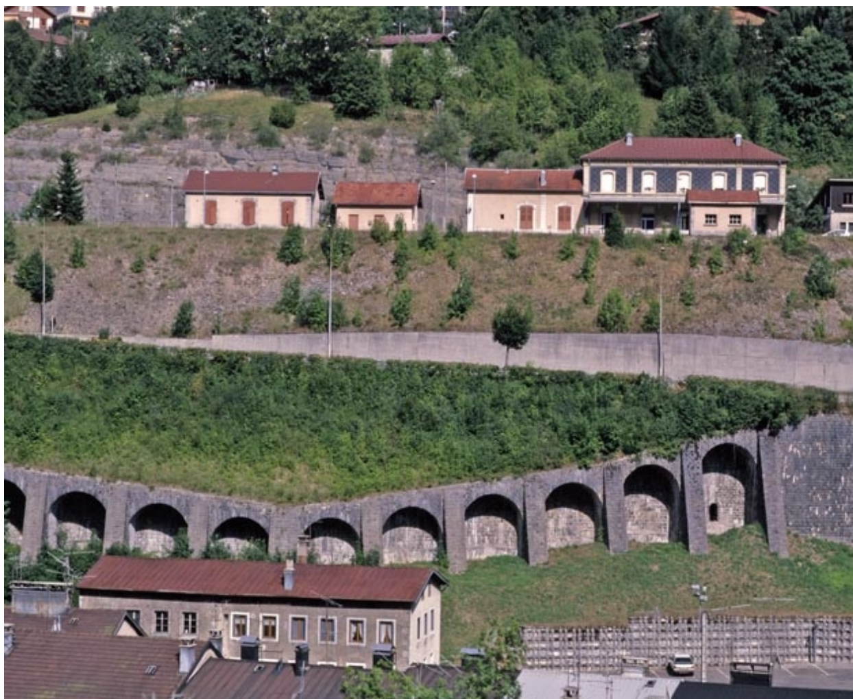
Bâtiment des voyageurs et logement, depuis l'ouest.
