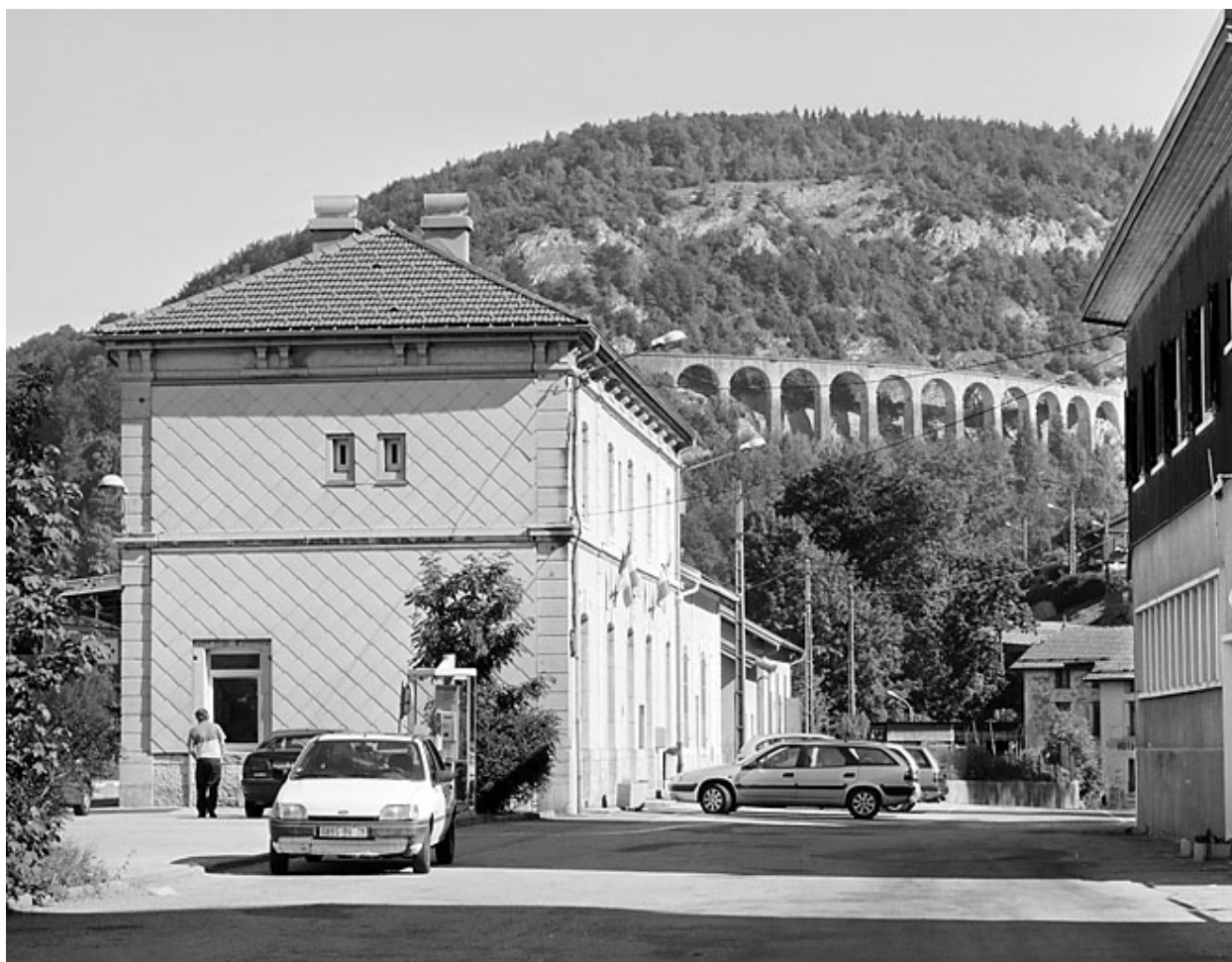
Bâtiment des voyageurs : façade latérale gauche.
