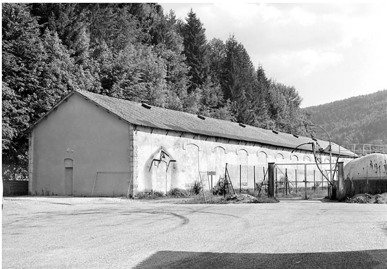
Remise ferroviaire, depuis le nord.
