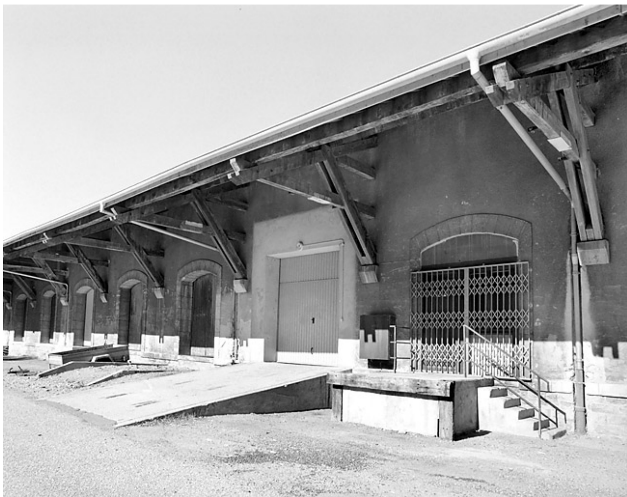
Entrepôt : façade antérieure.
