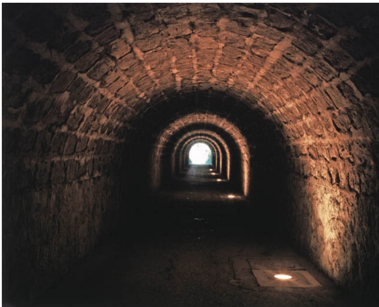
Passage souterrain (sous les voies) : intérieur.
