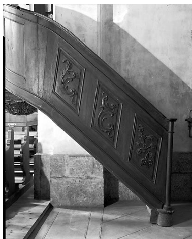
Détail de la rampe. Phot. Yves Sancey IVR43_19732500008V
