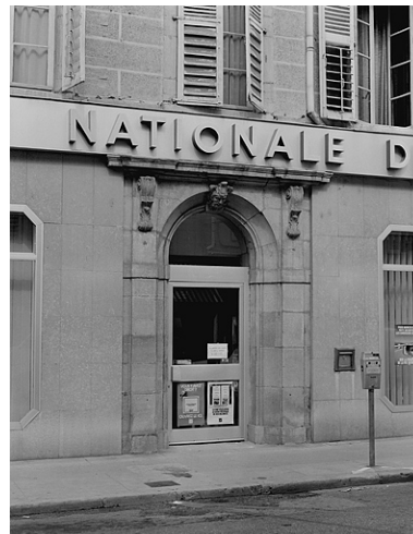
Façade antérieure, porte piétonne. Phot. Yves Sancey IVR43_19833900320X
