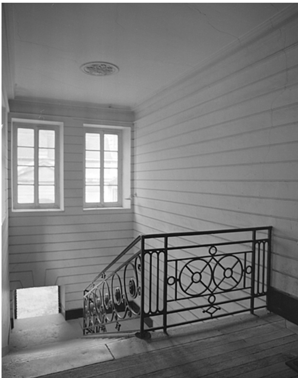
Vue de l'escalier depuis le palier.
