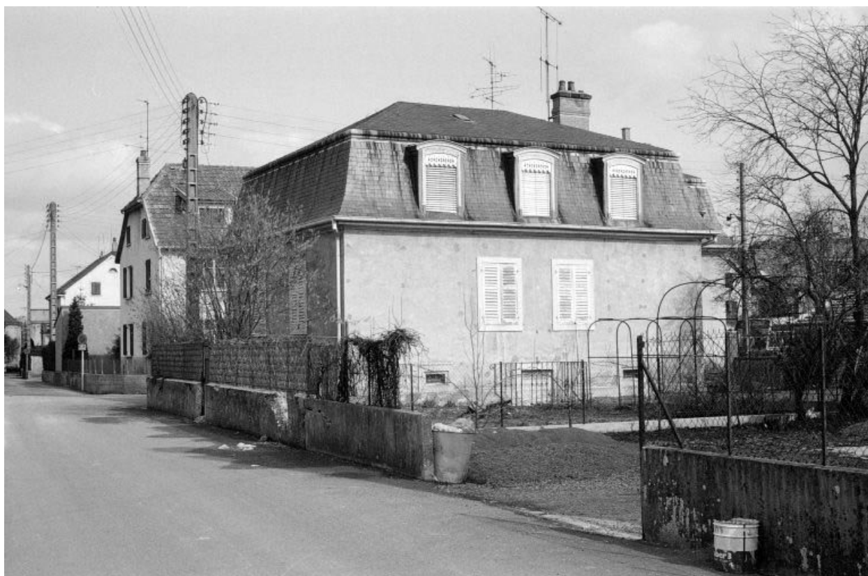
Façades postérieure et latérale droite.
