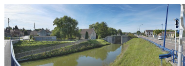
Le site d'écluse 04 est en amont de la maison éclusière. Maison IV dans le bief 05.
