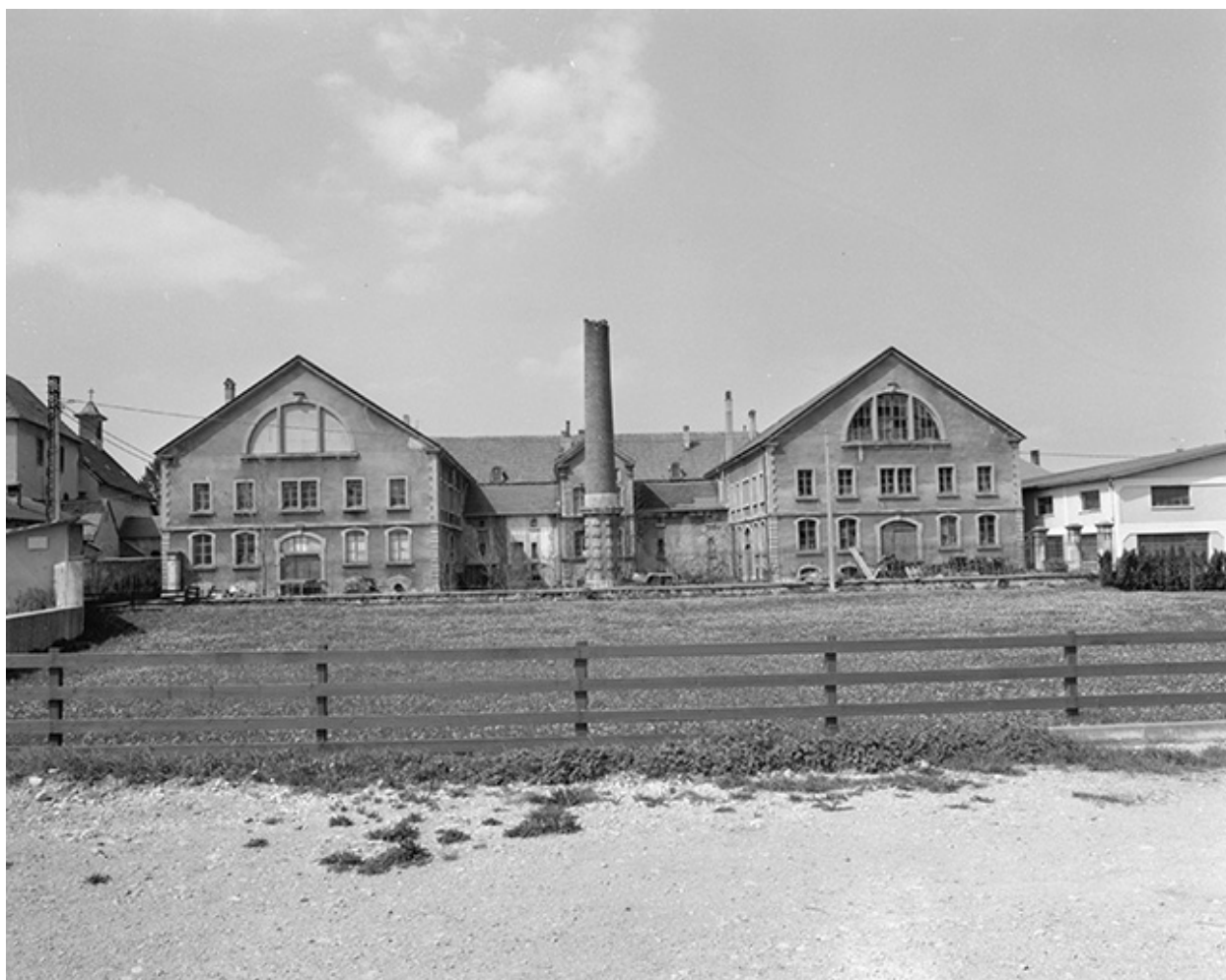
Façade postérieure des chais en 1980.
