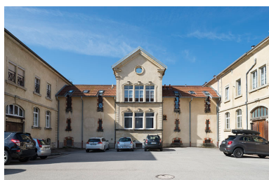
Vue axiale depuis la cour nord. Phot. Jérôme Mongreville IVR43_20172500339NUC4A
