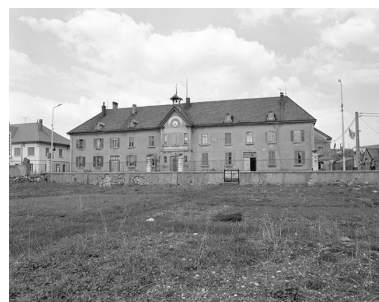
Façade antérieure en 1980. Phot. Yves Sancey IVR43_19802500168X
