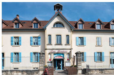
Partie centrale du bâtiment de la distillerie. Phot. Jérôme Mongreville IVR43_20162501182NUC4A
