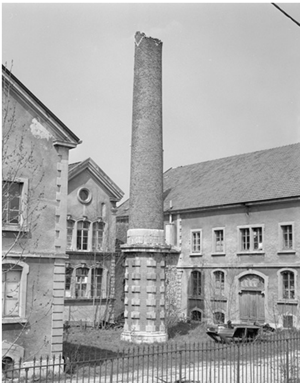
Cour des chais. Vue de la cheminée en 1980.
