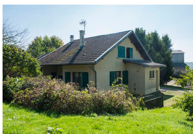
Angle nord-ouest du logement. Phot. Mary Ruffinoni IVR43_20137000687NUC4A
