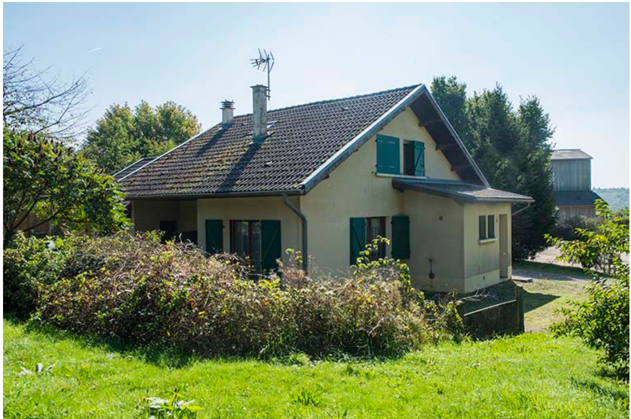
Angle nord-ouest du logement.
