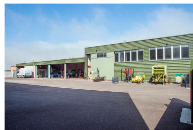
Façade antérieure sud de la halle d'agroéquipement.
