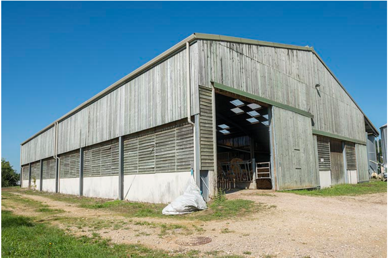
Angle sud-est du bâtiment de production laitière.
