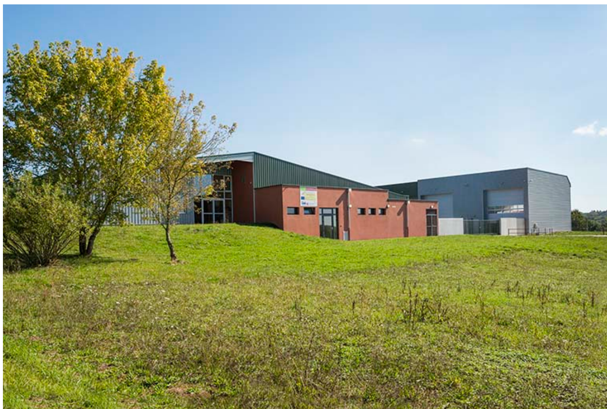
Les deux halles vues du nord-ouest.
