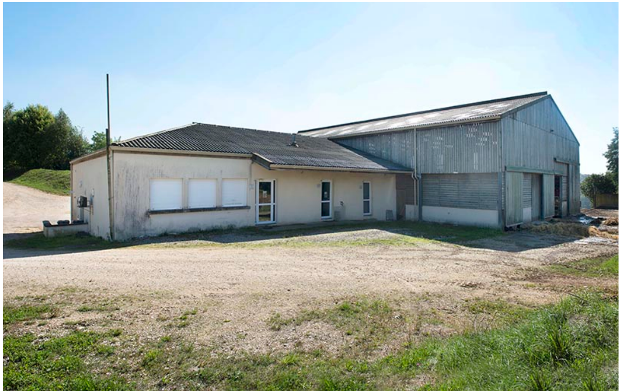
Angle nord-ouest du bâtiment de production laitière.
