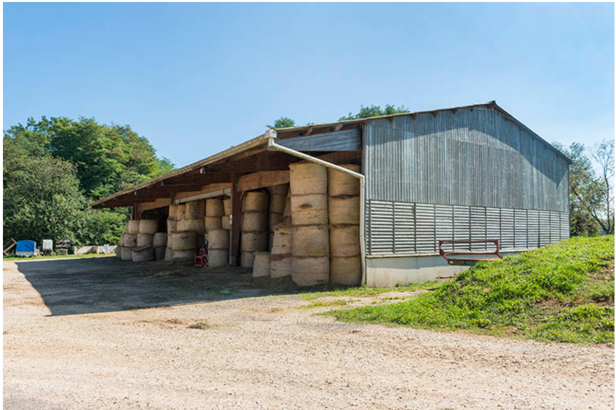
Angle ouest du hangar à fourrage sud-est.
