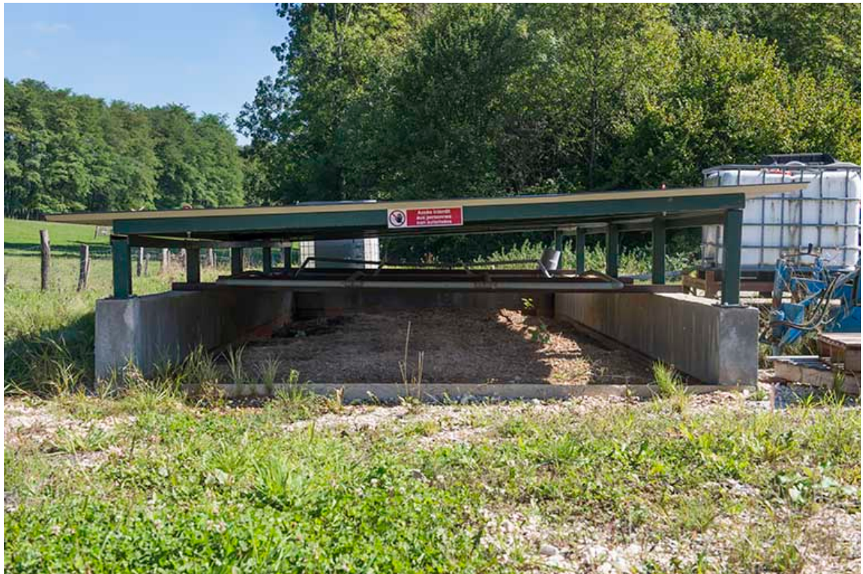
Aire de traitement des produits polluants usagés.
