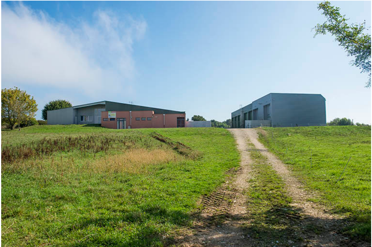
Vue d'ensemble, depuis les serres, à l'ouest.
