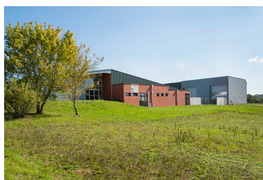
Les deux halles vues du nord-ouest.
