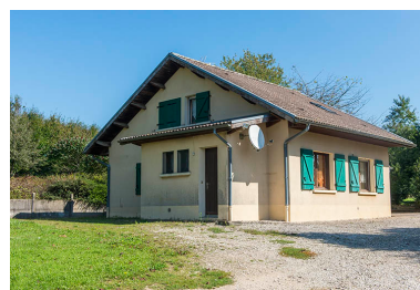
Angle sud-ouest du logement. Phot. Mary Ruffinoni IVR43_20137000686NUC4A
