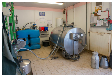
Tank à lait dans le bâtiment de production laitière. Phot. Mary Ruffinoni IVR43_20137000709NUC4A
