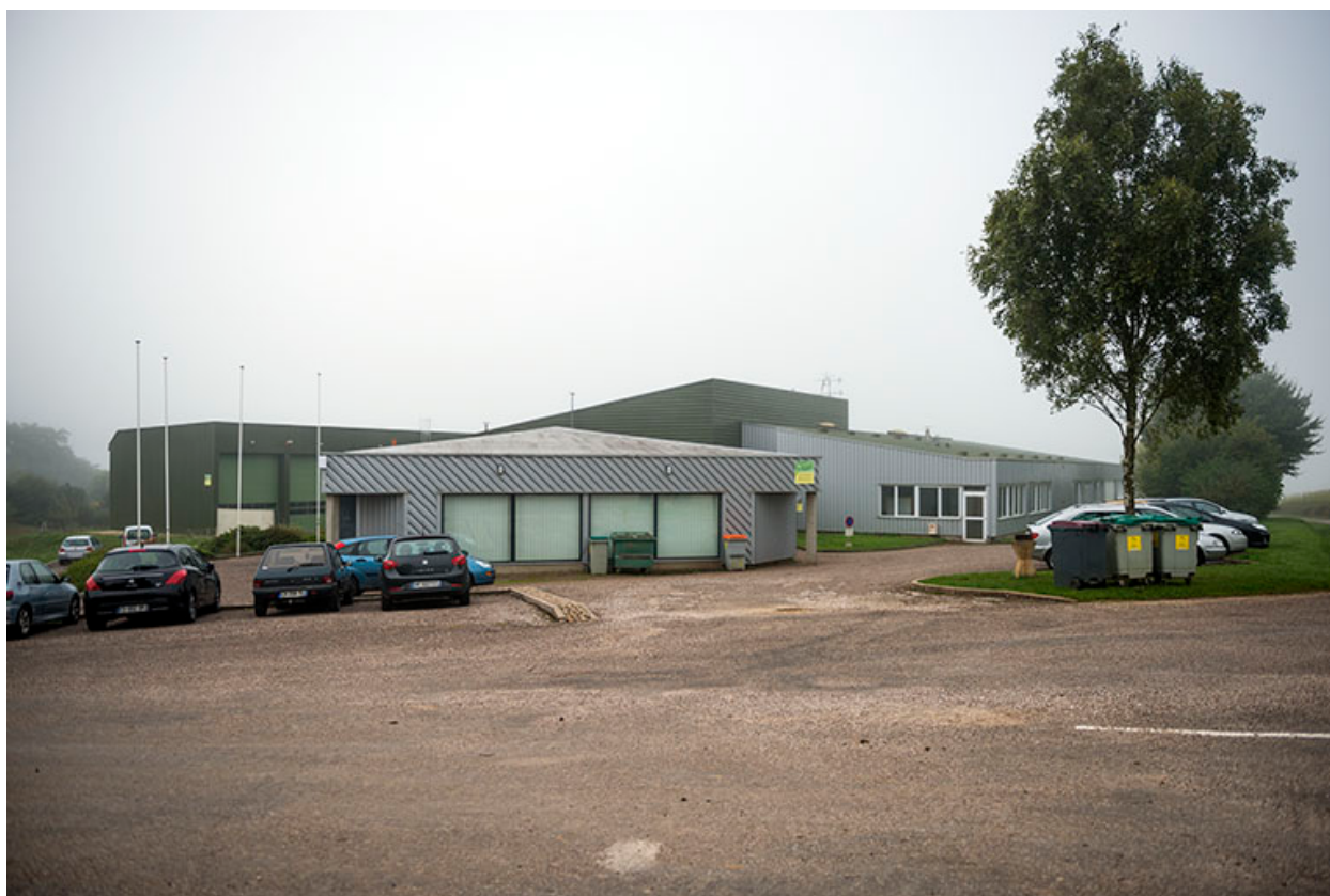
Façade nord-est du hall d'exposition.
