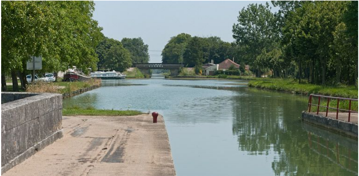
Vue d'ensemble du port.
