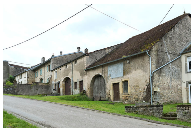
Alignement de fermes vigneronnes. Phot. Sonia Dourlot IVR43_20167000636NUC4A
