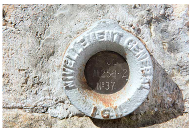
Répère de nivellement, église d'Aisey. Phot. Sonia Dourlot IVR43_20167000533NUC4A
