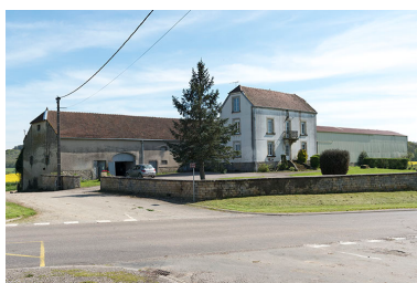
Ferme à l'entrée d'Aisey. Phot. Sonia Dourlot IVR43_20167000543NUC4A
