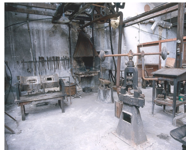
Vue de la forge. Phot. Yves Sancey IVR43_20022500821XA
