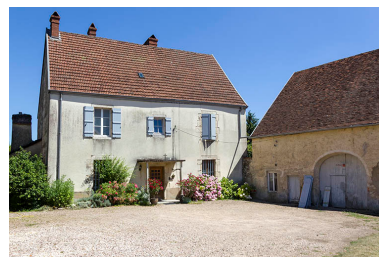
Vue d'ensemble depuis l'entrée. Phot. Sonia Dourlot IVR43_20157000406NUC2A
