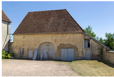
Vue générale du bâtiment agricole sur cour. Phot. Sonia Dourlot IVR43_20157000407NUC2A
