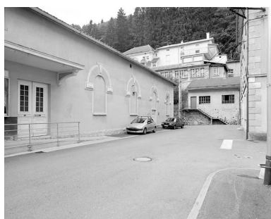
Elévation antérieure, de trois quarts gauche. Phot. Yves Sancey IVR43_20033900227X
