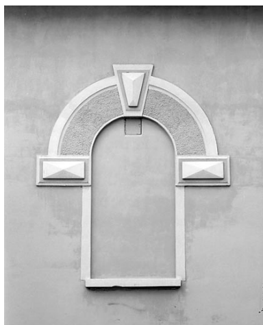
Détail d'une baie. Phot. Yves Sancey IVR43_20033900230X
