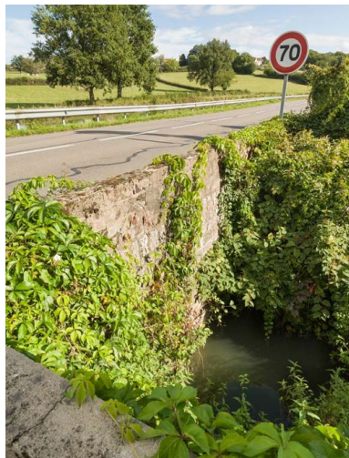
Vue de l'aqueduc. Phot. Pierre-Marie Barbe-Richaud IVR26_20177100306NUC2A
