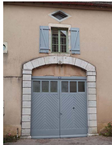
Détail du porche Phot. Sabrina Dalibard IVR43_20137000800NUC2A
