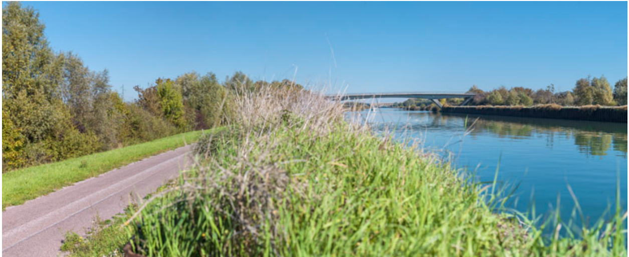
Vue d'ensemble, d'aval.
