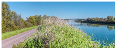
Vue d'ensemble, d'aval. Phot. Thierry Kuntz IVR26_20172100502NUC4A
