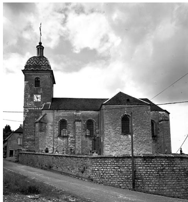
Façade latérale sud. Phot. Yves Sancey IVR43_19777000116V
