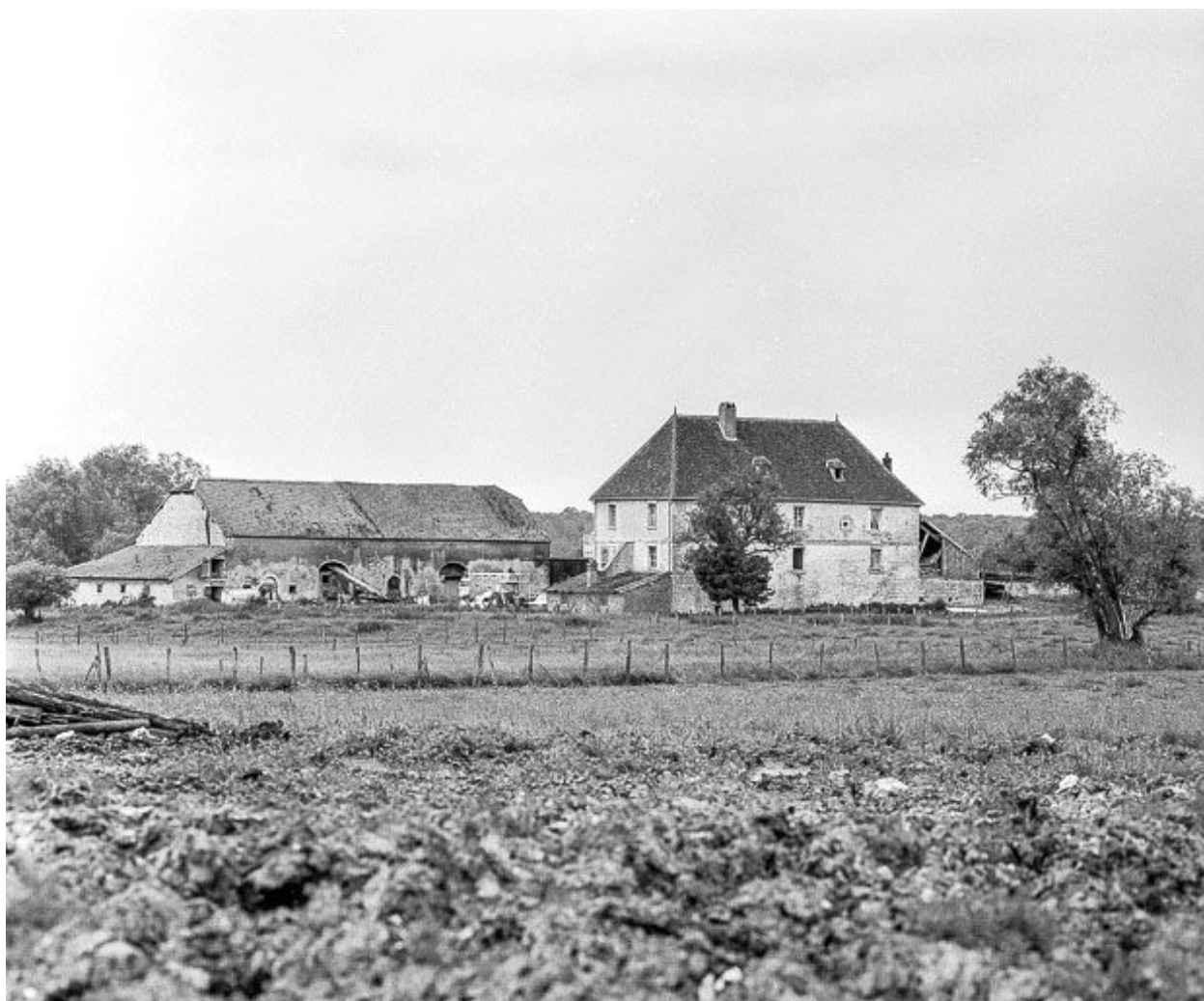
Demeure dite le Château, située rue de l'Eglise.
