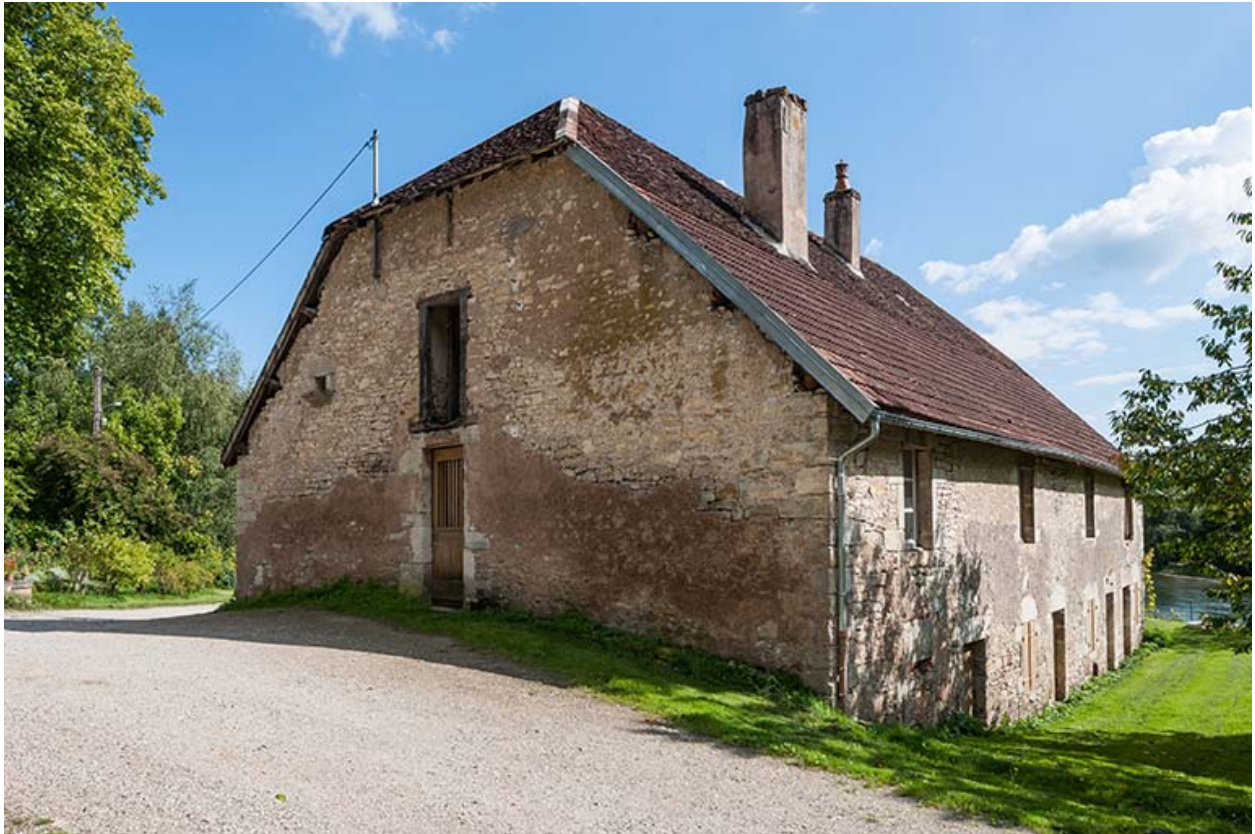
Logement d'ouvriers vu de trois quarts arrière.
