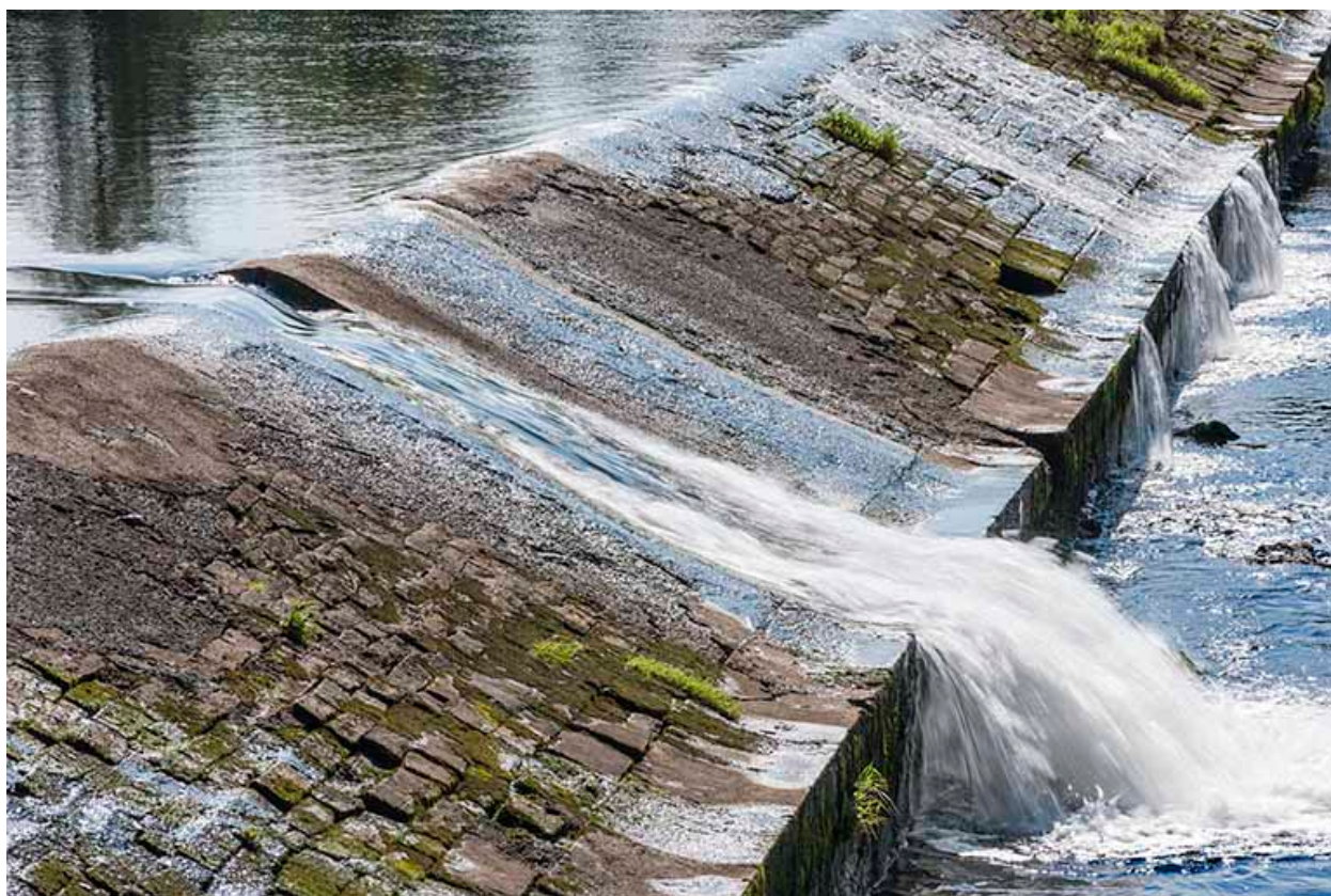
Vue de détail du barrage.
