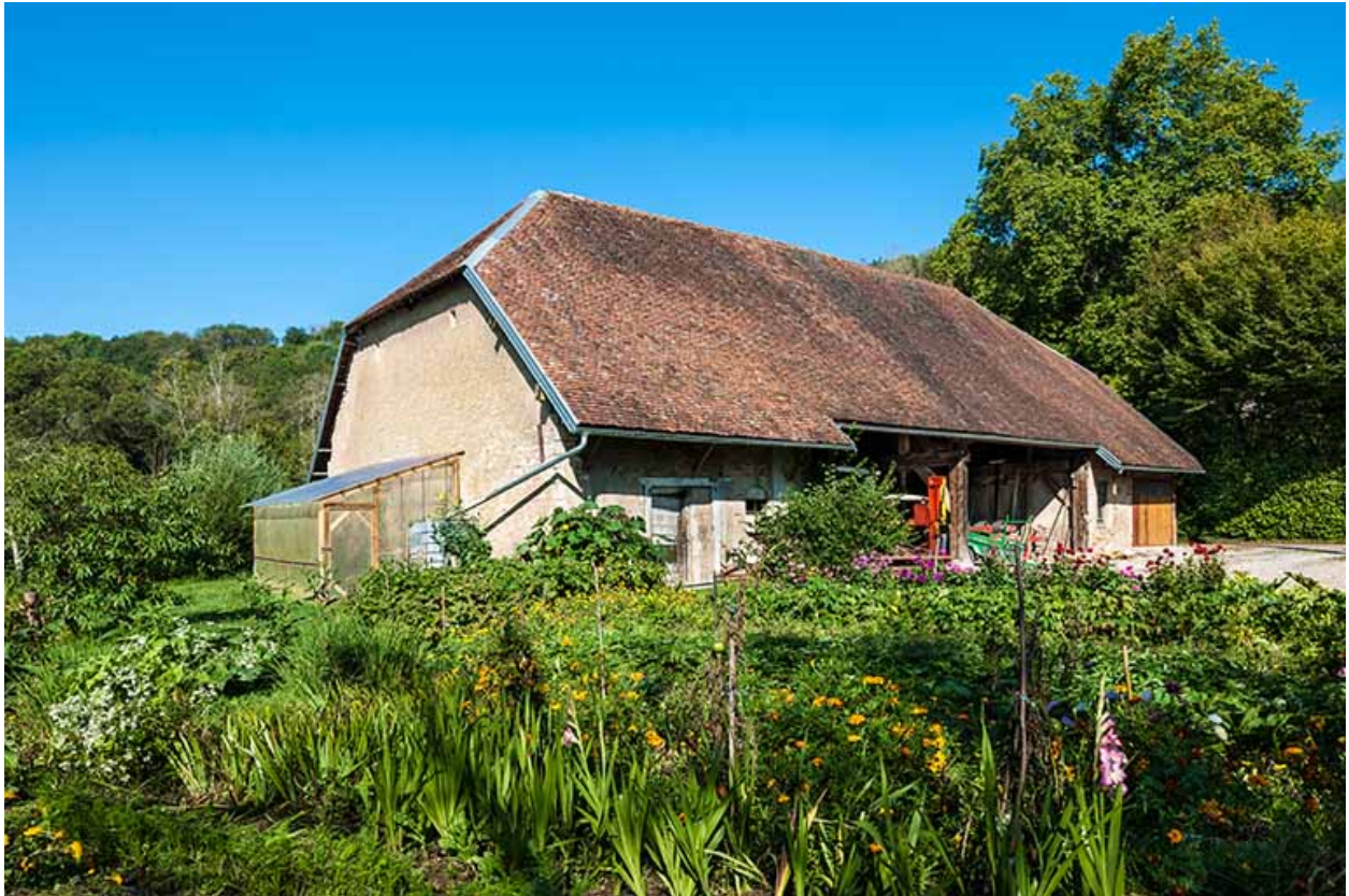
Vue du magasin industriel depuis le sud-est.
