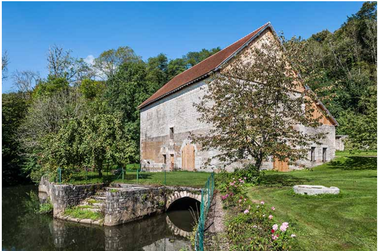
Bâtiment du haut fourneau depuis le sud-est.
