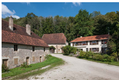
Logements depuis la cour. Phot. Jérôme Mongreville IVR43_20142501232NUC4A
