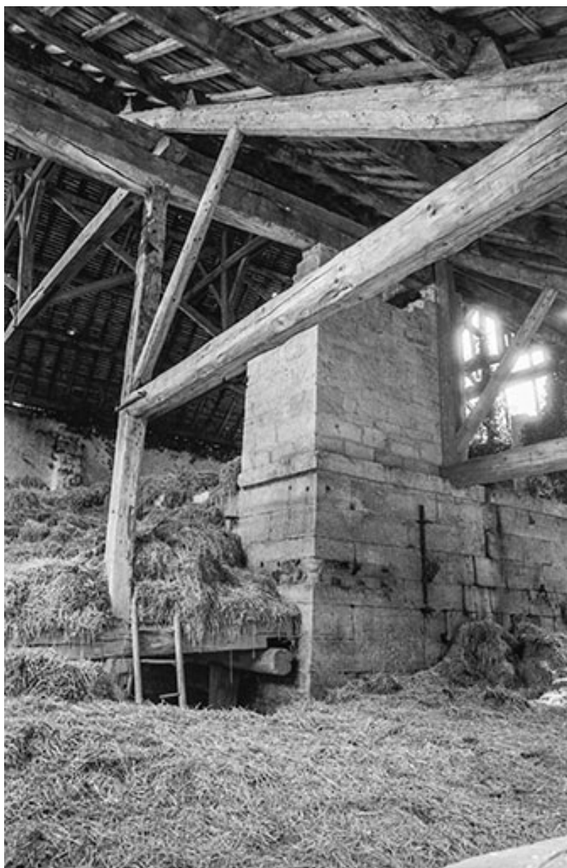
Partie supérieure du haut fourneau en 1980.
