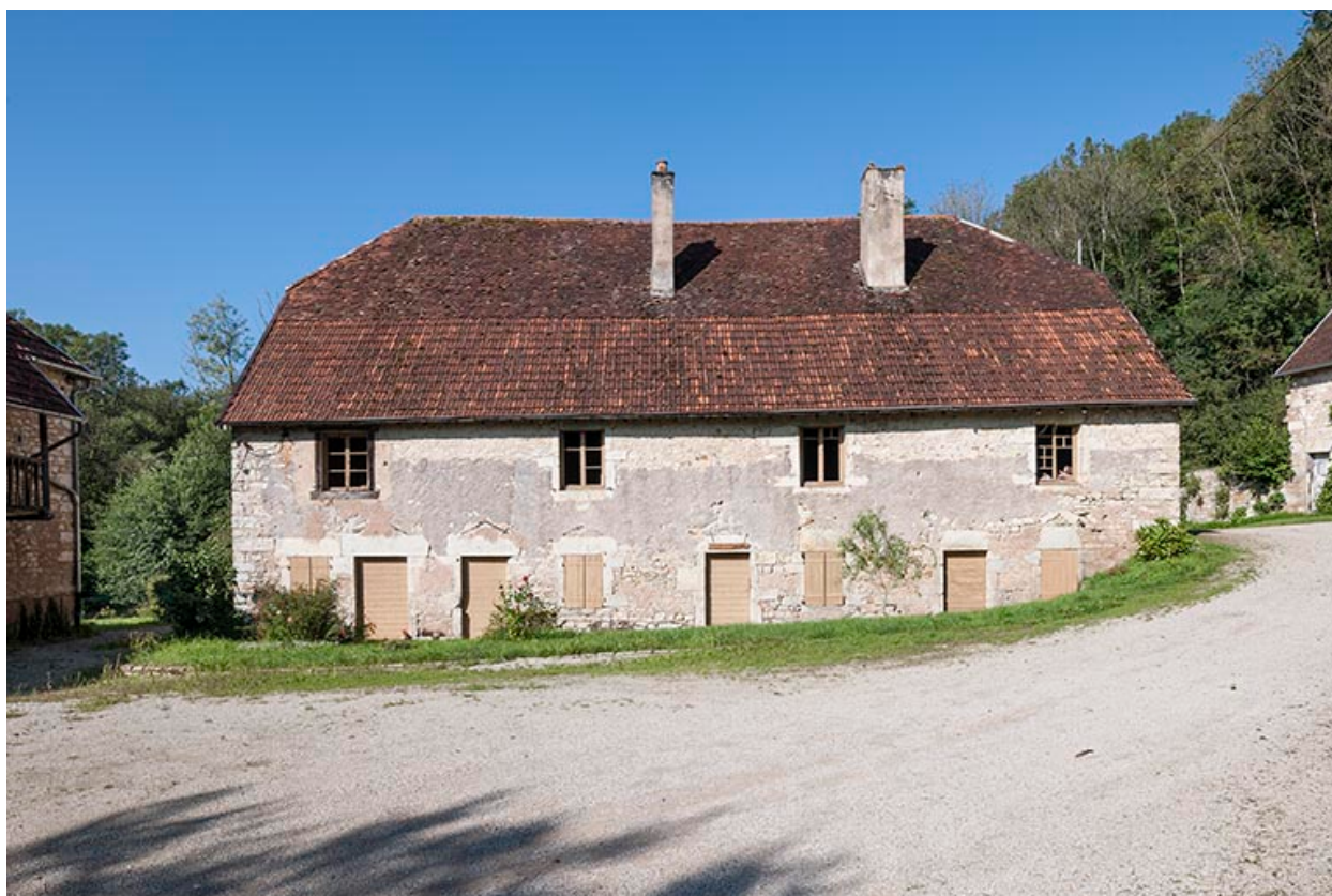
Logement d'ouvriers. Façade est.
