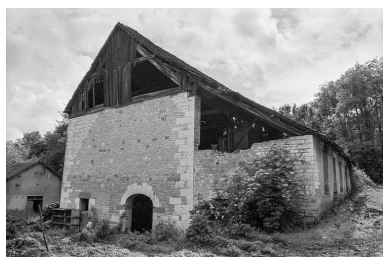
Bâtiment du haut fourneau en 1980. Phot. Bernard Lardière IVR43_19802500395Z
