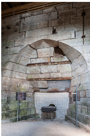
Base du haut fourneau (côté sud) et ouverture de la soufflerie. Phot. Jérôme Mongreville IVR43_20142501210NUC4A
