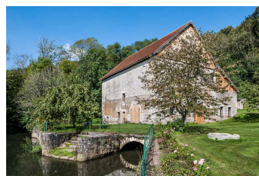
Bâtiment du haut fourneau depuis le sud-est.
