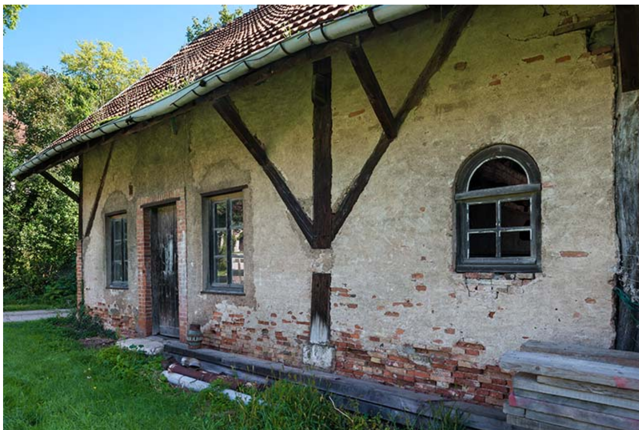
Détail de la façade ouest du magasin.
