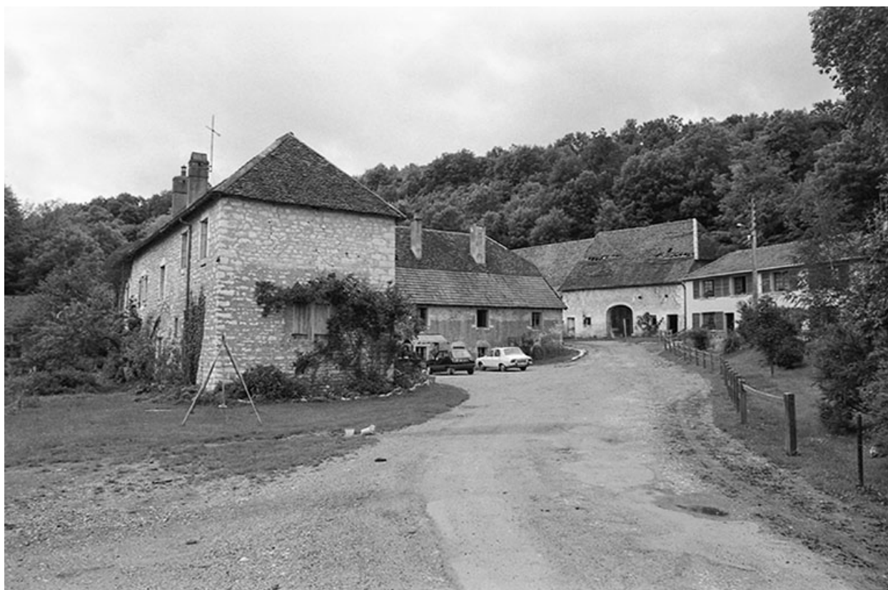
Vue d'ensemble depuis l'entrée en 1980.
