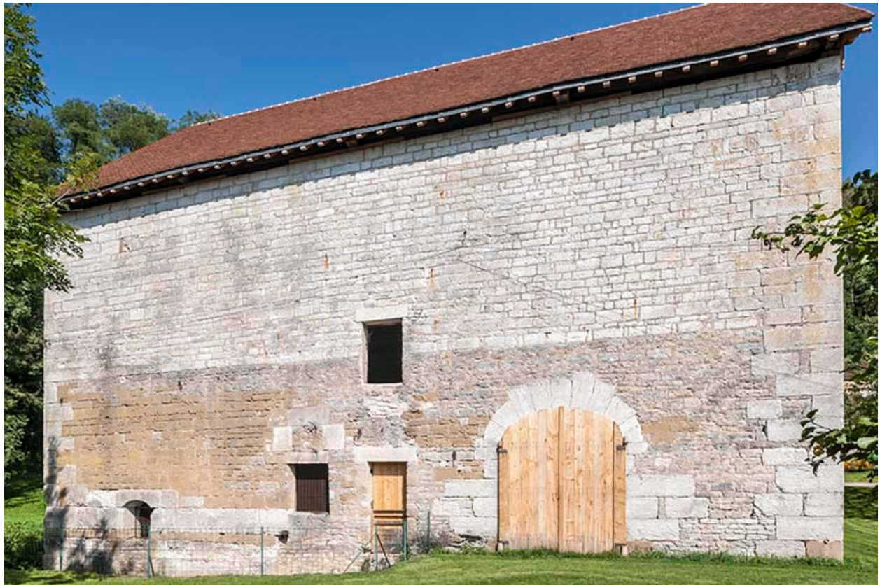
Façade sud du bâtiment du haut fourneau.
