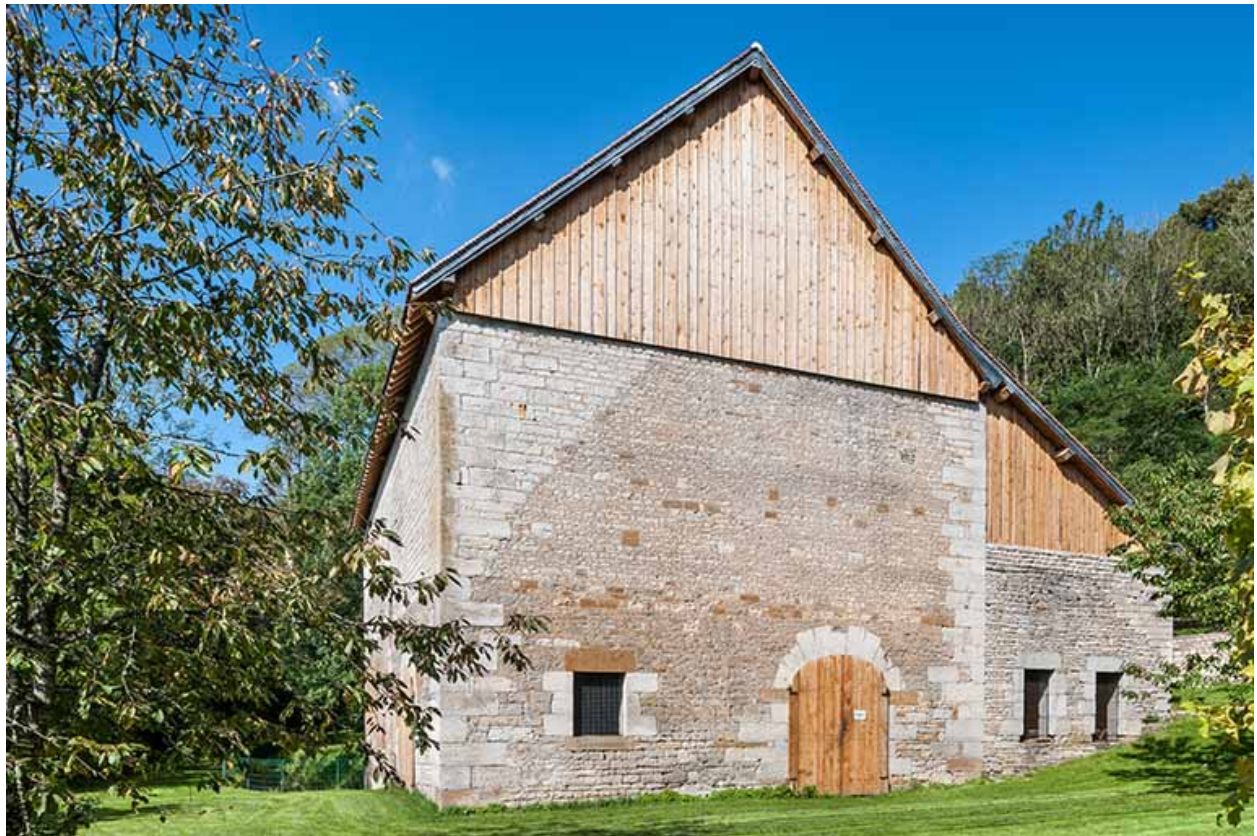
Pignon est du bâtiment du haut fourneau.
