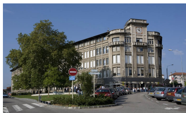
Vue d'ensemble de l'école, depuis l'est. Phot. Yves Sancey IVR43_20062501156NUCA
