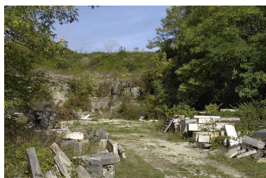
Vue d'ensemble du front de taille nord. Phot. Jérôme Mongreville IVR43_20053900474NUCA
