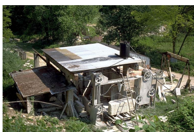
Vue plongeante sur l'atelier du tailleur de pierres. Au premier plan, la scie Perrot Aubertin. Phot. Laurent Poupard IVR43_19893900175ZA
