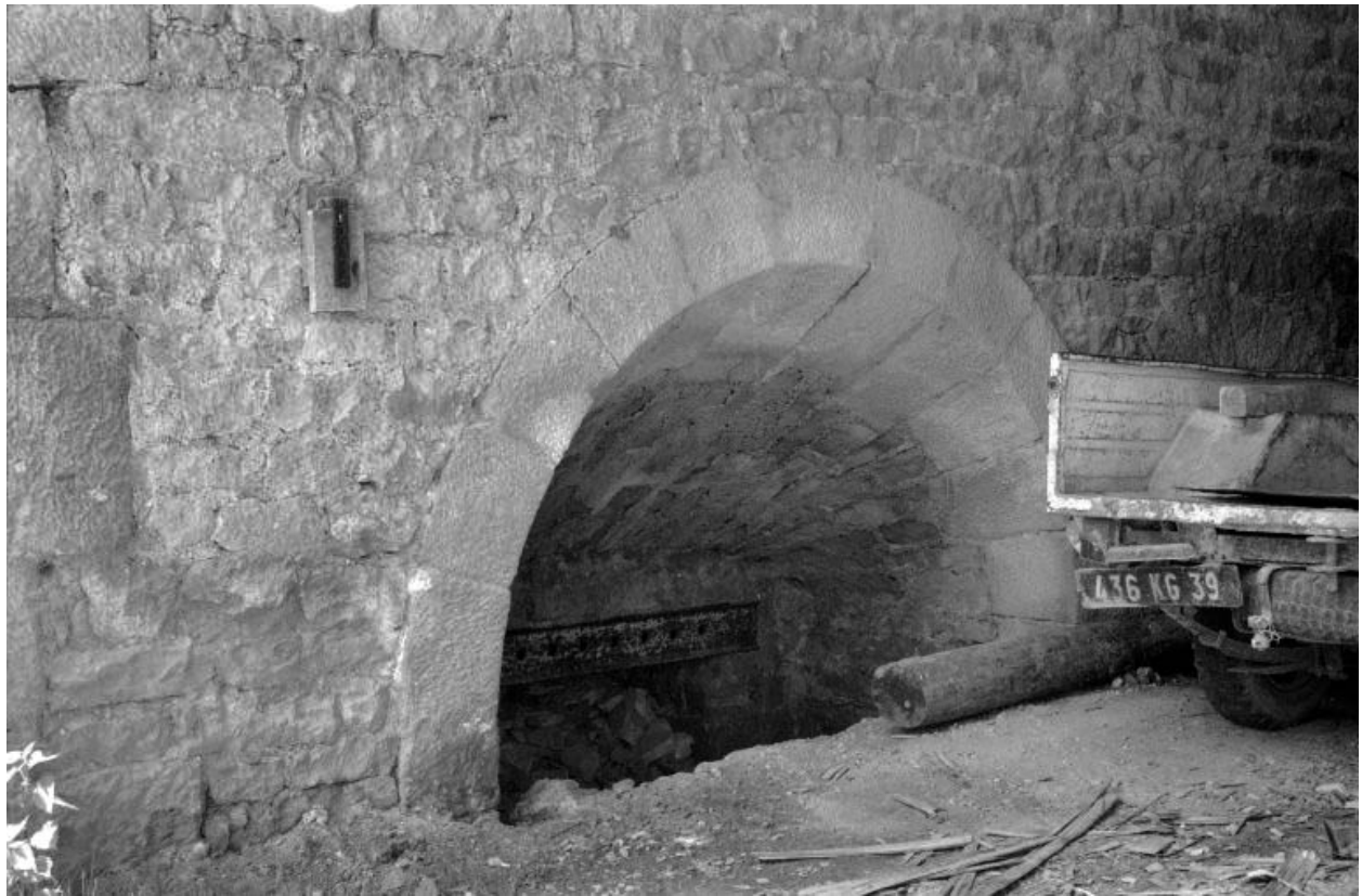
Ouverture de défournement nord.
