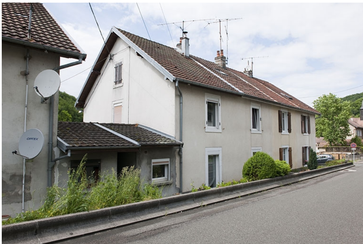
Habitation ouvrière vue de trois quarts.
