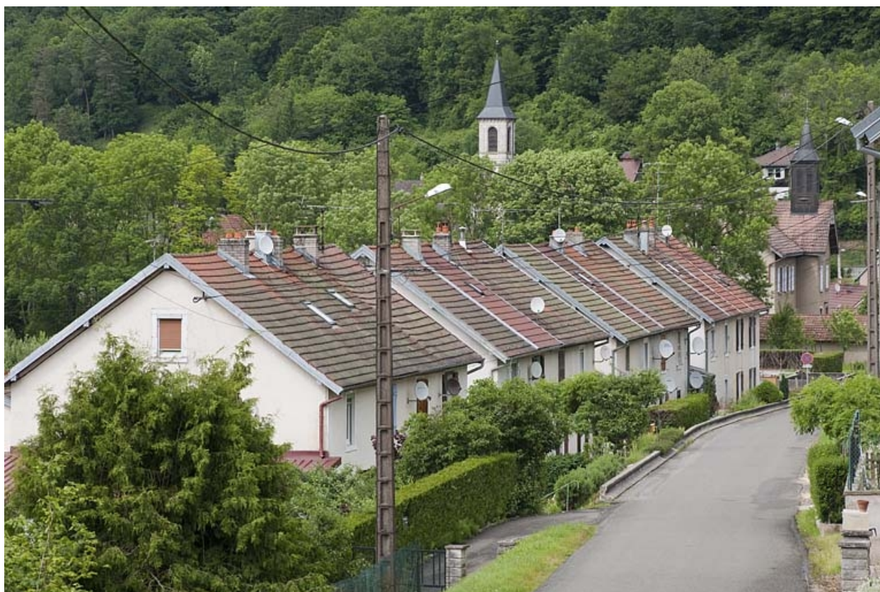
Logements ouvriers depuis le sud.
