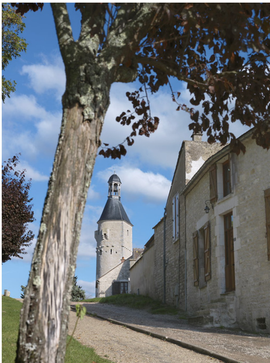
Vue d'ensemble de la tour de l'horloge.
