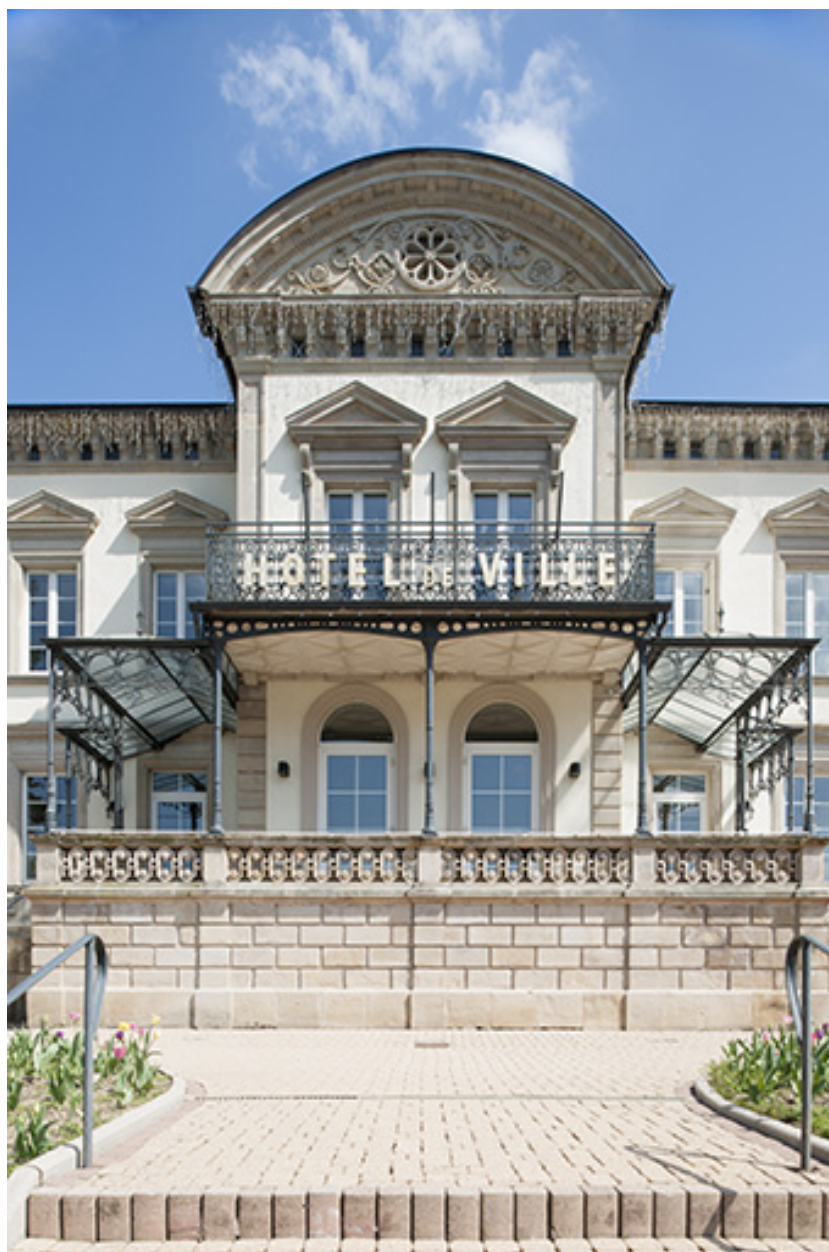
Façade antérieure. Détail de l'avant-corps central.
