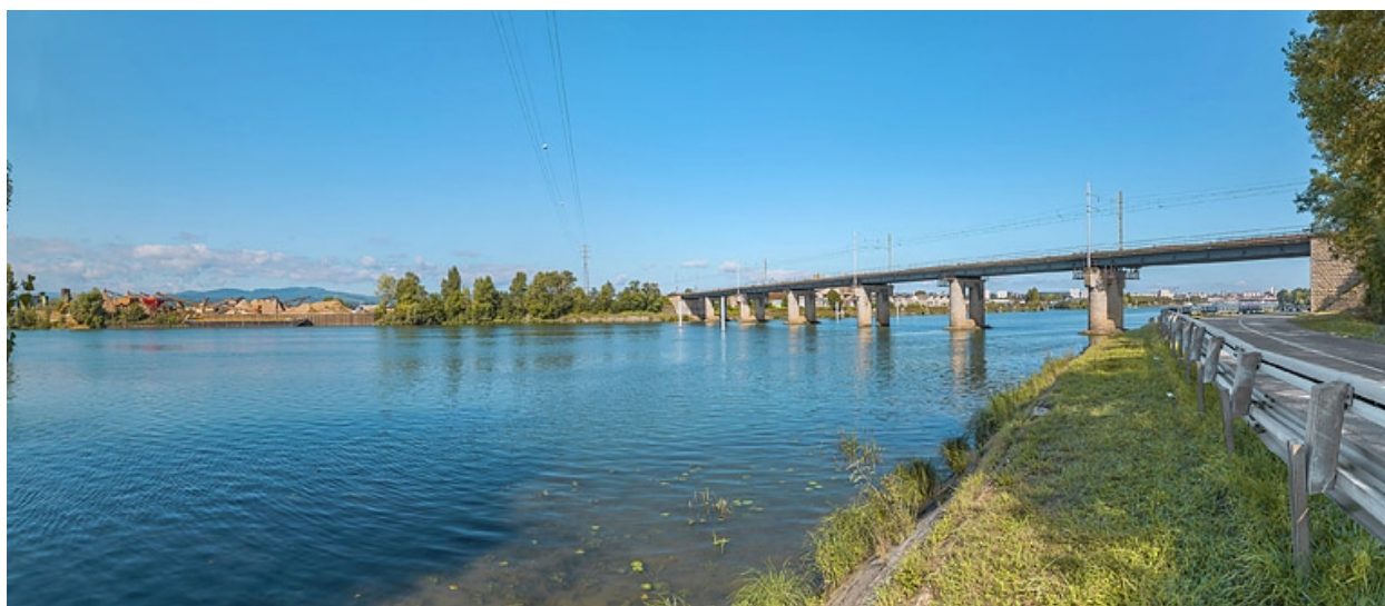
Le pont vu d'aval, rive gauche.
