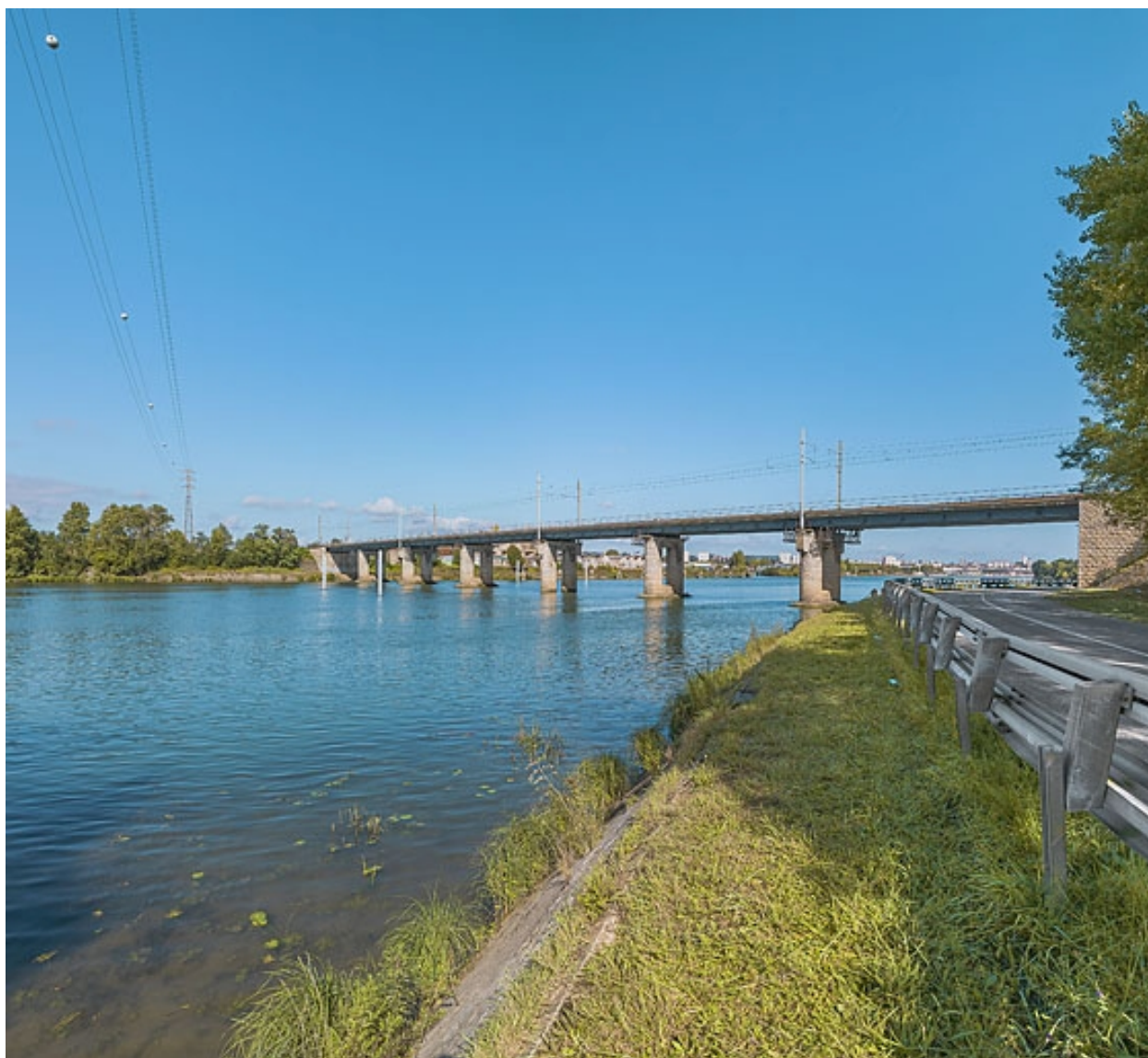
Le pont vu d'aval, rive gauche.
