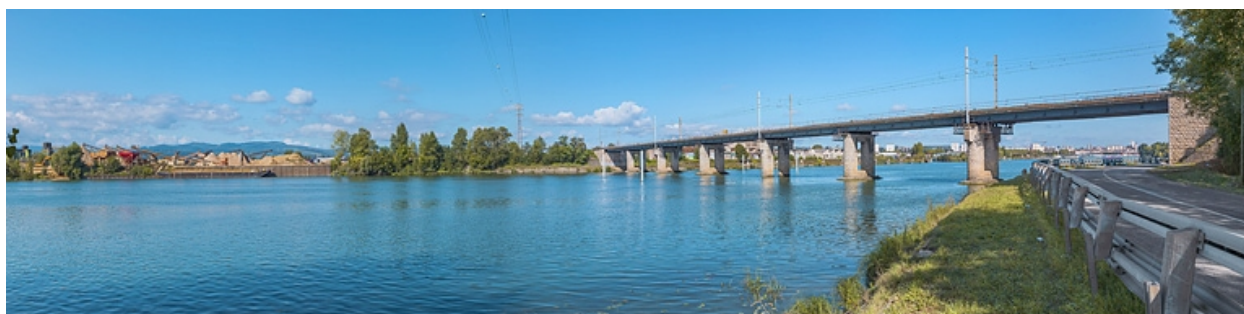
Le pont vu d'aval, rive gauche.
