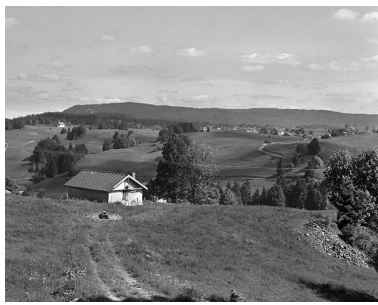
Etable à vaches situées au lieudit La Grenotte. Phot. Jérôme Mongreville IVR43_20013900485X
