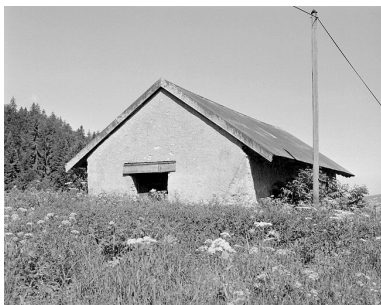
Façade antérieure d'une étable à vaches. Phot. Jérôme Mongreville IVR43_20003900166X
