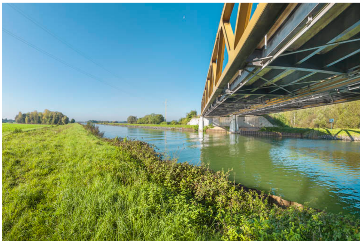
Le tablier du pont.
