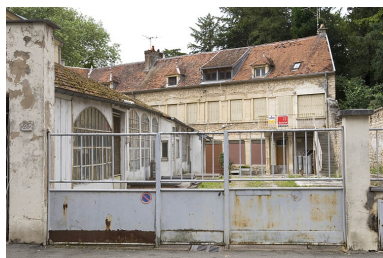
Vue d'ensemble depuis la rue Victor Hugo.
