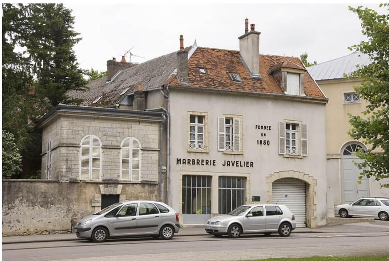
Vue d'ensemble depuis la rue Revon.
