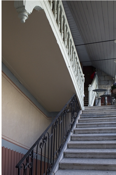
Escalier à cage ouverte : détail de la dernière volée en charpente. Phot. Yves Sancey IVR43_20102501129NUC2A
